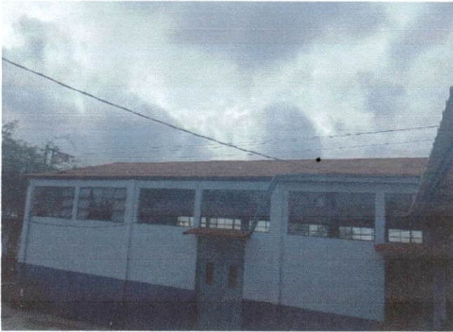
VISTA GENERAL DEL TECHO DE LÁMINA DE ZINC A CAMBIAR POR LÁMINA TROQUELADA EN EL SUM
