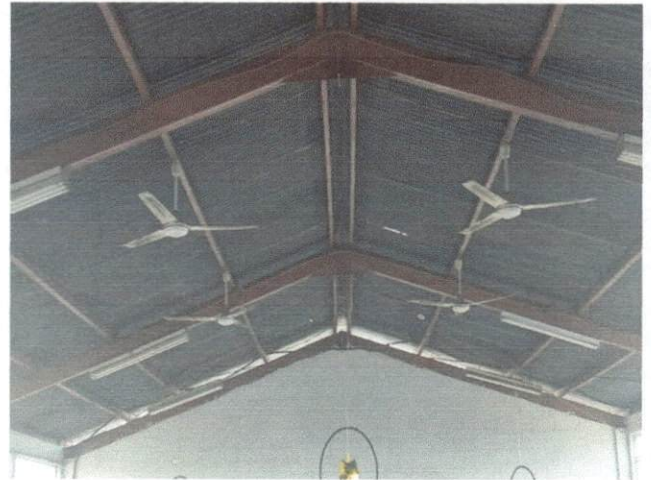
VISTA INTERIOR DE LÁMINAS DE ZINC
