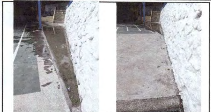
Foto 2: SUSTITUCION DE CUNETA MAS REJILLA METALICA
