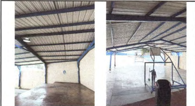
Foto 3: SUMINISTRO E INSTALACION DE LAMPARAS (INCLUYE FLIPPON, ENTUBADO, CABLEADO )
