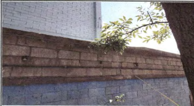
Foto 1: SUMINISTRO E INSTALACION DE RAZZOR RIBON ( CUANDO HAY PARTIDOS DE FUTBOL EN EL ESTADIO, PERSONAS ENTRAN AL ESTABLECIMIENTO )
