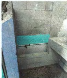
Foto 1: Sustrucción de mingitorio de concreto por mingitorio individual
