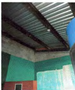
Foto 9: Instalación de energía eléctrica en área de baños de niños.
