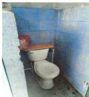
Foto 11: Sustrución de sanitarios en el área de baños de niños.
