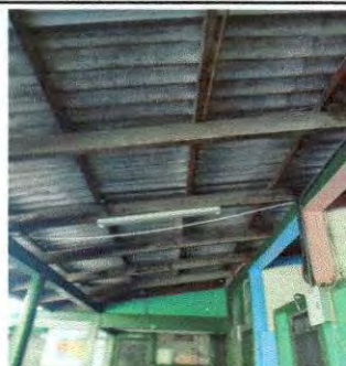
Foto 10: sustitución de lámina de duralita por lámina troquelada y mantenimiento de estructura de metal en el área de corredor
