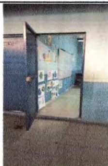
Sustitución de cerraduras y mantenimiento de puertas
