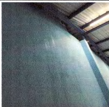
Colocación de canal para recoger el agua que se filtra en la pared de la cocina.
