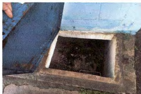
Instalación de bomba a tanque cisterna y mantenimiento
