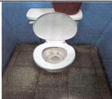
Sustitución de sanitarios e instalación de nuevos
