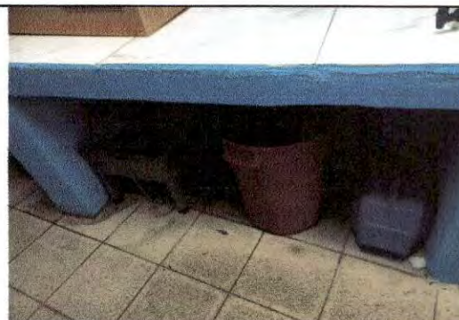
Colocación de azulejos y puertas en muebles de cocina.
