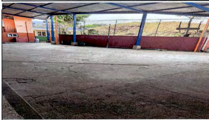
Foto 5: SUSTITUCIÓN DE LOSA DE PATIO DE CEMENTO DEBIDO A AGRIETAMIENTO POR PISO TIPO PORCELANATO
