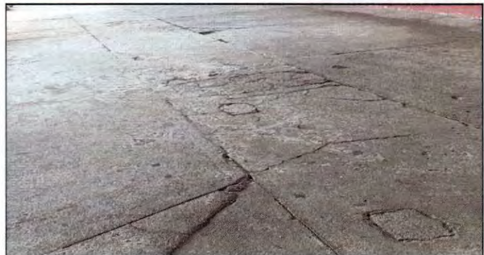
Foto 6: SUSTITUCIÓN DE LOSA DE PATIO DE CEMENTO DEBIDO A AGRIETAMIENTO POR PISO TIPO PORCELANATO
