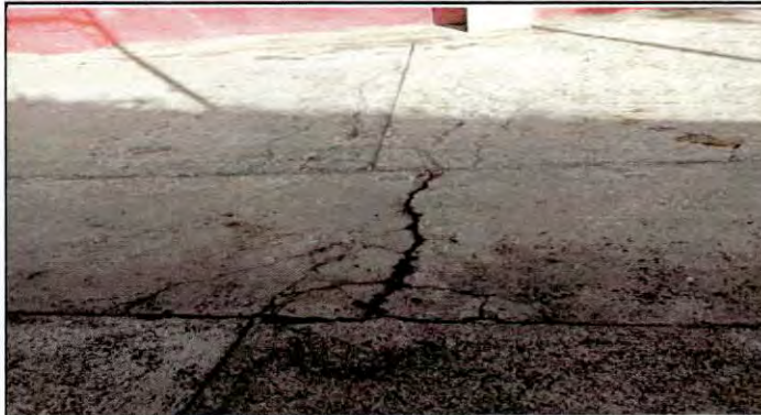
Foto1: SUSTITUCIÓN DE LOSA DE PATIO DE CEMENTO DEBIDO A AGRIETAMIENTO POR PISO TIPO PORCELANATO
