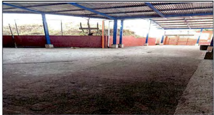
Foto 4: SUSTITUCIÓN DE LOSA DE PATIO DE CEMENTO DEBIDO A AGRIETAMIENTO POR PISO TIPO PORCELANATO
