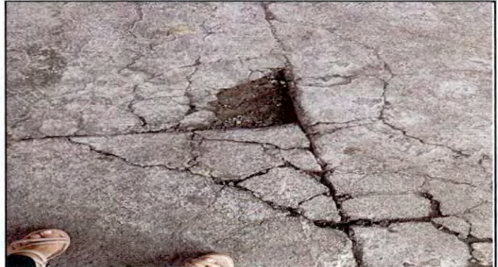
Foto 2: SUSTITUCIÓN DE LOSA DE PATIO DE CEMENTO DEBIDO A AGRIETAMIENTO POR PISO TIPO PORCELANATO
