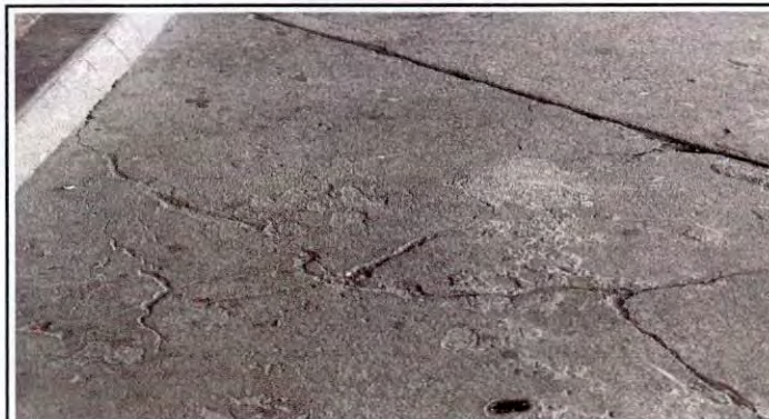
Foto 3: SUSTITUCIÓN DE LOSA DE PATIO DE CEMENTO DEBIDO A AGRIETAMIENTO POR PISO TIPO PORCELANATO
