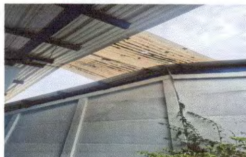
Foto 6: cambio de lámina de mala calidad.
