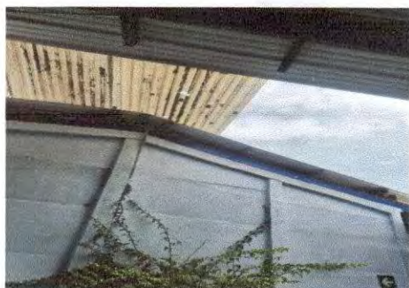
Foto 5: cambio de estructura.
