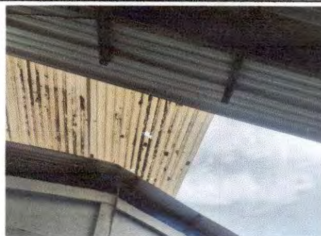
Foto 4: Cambio de lámina en mal estado.
