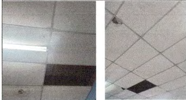
suministro de fibra mineral para cielo suspendido en cocina
