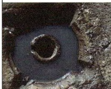
REEMPLAZO DE REPOSADERA EN MAL ESTADO
