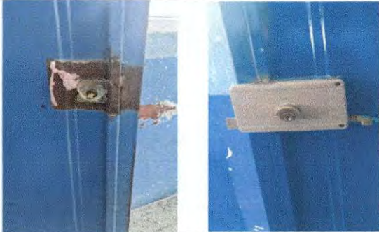
cambio de chapas de registro a puertas de 3 aulas.
