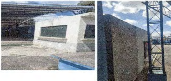
COLOCACIÓN DE LÁMINA PARA VOLADIZO DE TIENDA
