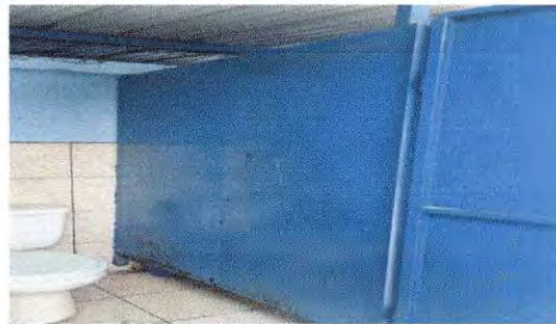
REPARACIÓN DE PARED DIVISORA DE SANITARIOS DEL SALON DE CLASES No. 10
