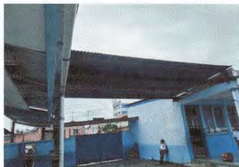
Cubierta de lámina sobre entrada principal
