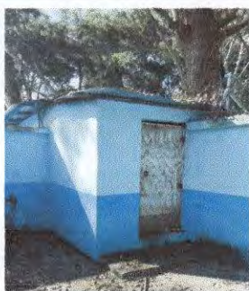
Servicio sanitario y sus accesorios, colocación de azulejo en servicio sanitario.
