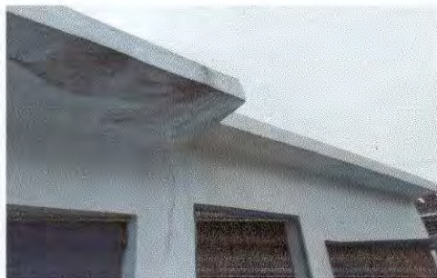
Estructura de techo sobre pestaña existente para mayor sombra.
