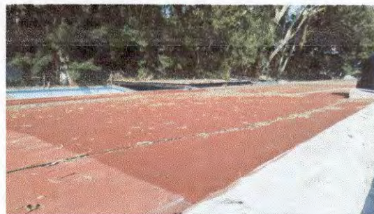
Impermeabilización de losa sobre aulas
