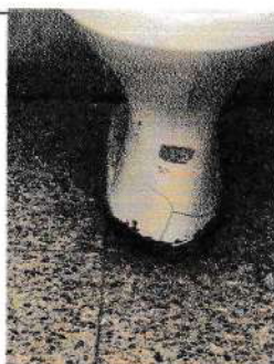
Cambio de Sanitarios a fluxometro
