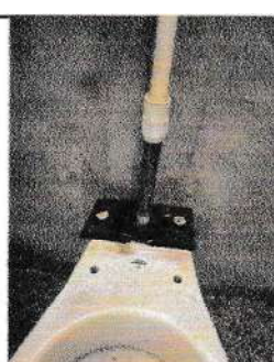
Cambio de Sanitarios a fluxometro
