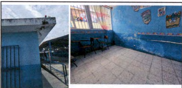
Foto 5: BAJADAS DE AGUA PLUVIAL, IMPERMEABILIZACION EN MURO (ACTULAMENTE HAY HUMEDAD EN LOS MUROS )
