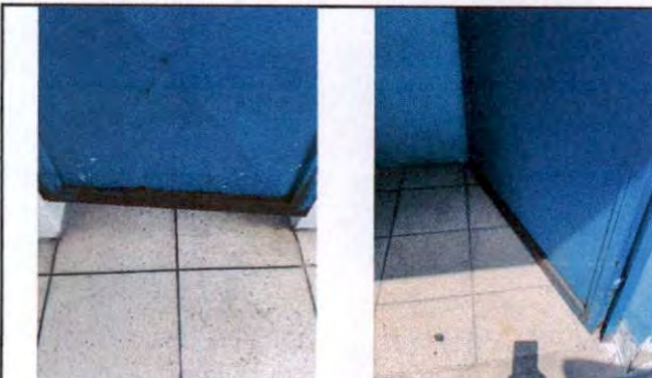
Foto 5: REPARACION DE PUERTAS EN BAÑOS Y EN COCINA
