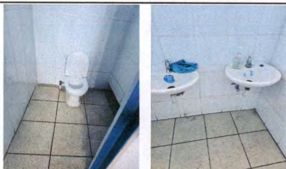
Foto 3: SUSTITUCION DE INODORO BABY DEBIDO A LOS CONSTANTES TAPONAMIENTOS QUE SE DAN. CAMBIO DE LLAVE DE LAVAMANOS Y DESAGUES
