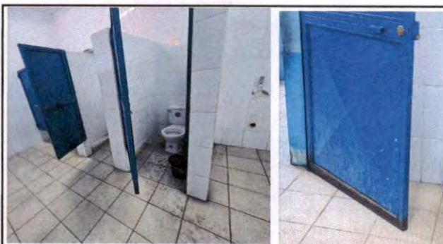
Foto 4: REPARACION DE PUERTAS EN LA PARTE INFERIOR
