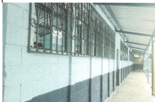
PINTURA EXTERNA DEL NIVEL PREPRIMARIO Y PINTURA DE BALCONES
