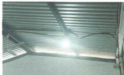
Foto 6: SUSTITUCION DE VENTILADORES , COLOCARA CEDAZO E 3 AULAS , SUSTITUCION DE 8 VENTILADORES PARA 4 AULAS
