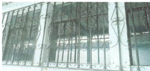
Foto 3: EN ESTA PARTE SE MUESTRA LA SUSTIRUCION DE VENTAS A PVC
