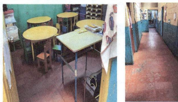
Foto 4: Piso existente en aulas y corredores, se instalara piso ceramico
