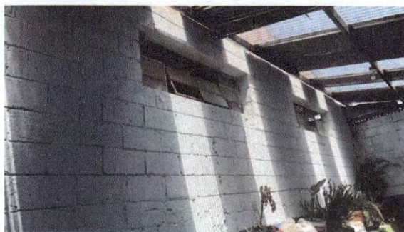
Foto 3: Ventanas existentes, se cambiarian por ventanas PVC
