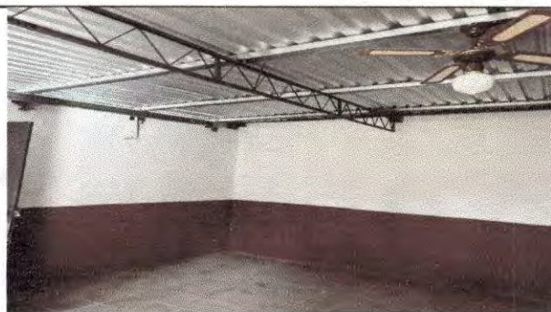
Foto 6: Remozamiento en muro de cocina.
