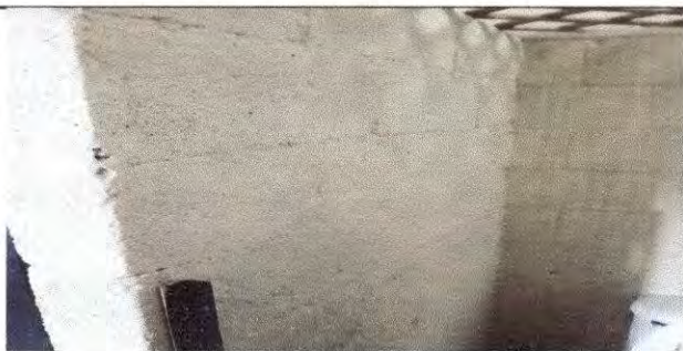
Foto 5: sustitución y reparación de cernido de paredes individuales
