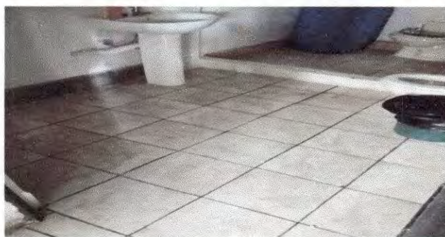
Foto 3: sustitución y reparación del azulejo en área de baño de maestros
