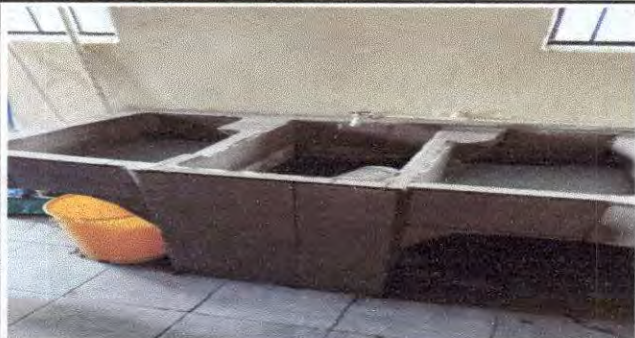
Foto1: sustitución de pilas de dos lavaderos en el área de los baños de los niños de preparatoria
