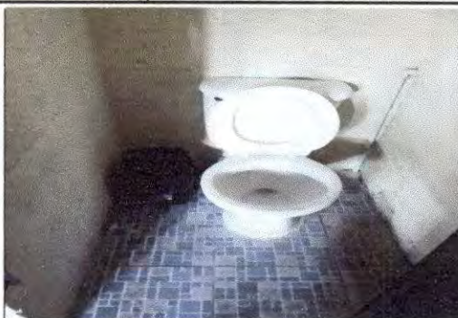
Foto 2: sustitución y reparación de losa sanitarios
