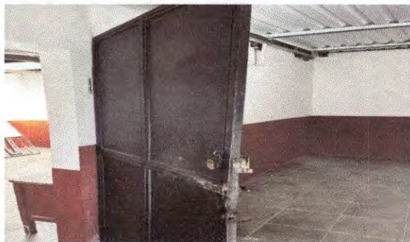
Foto 1: Sustrucción de puerta en el área de cocina
