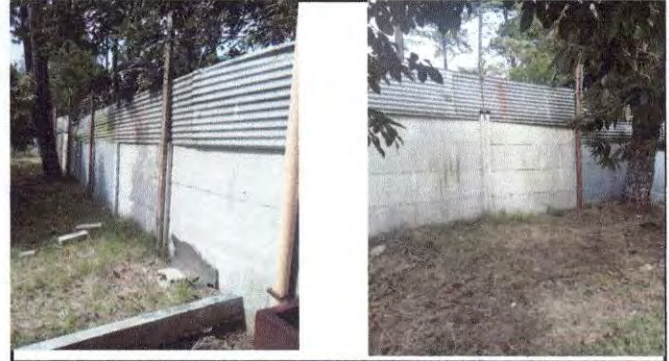
Foto 2: Muro perimetral de 30.80 metros lineales a 3 metros de altura util, con una profundidad de 0.80 cm de poste, por seguridad del establecimiento.
