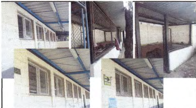
Foto 3: 25.8 mts cuadrados de hierro redondo para seguridad de los baños y pilas del establecimiento. Con extracción de maya.
