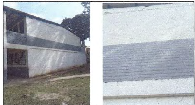
Foto 4: Reparacion de muro vertical con impermeabilizante por fisuras en la pared y humedad internas externas.
