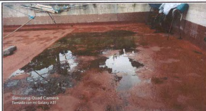
Reparación de pañuelos (el renglón incluye: levantado de mezción y tallado de pañuelos)
