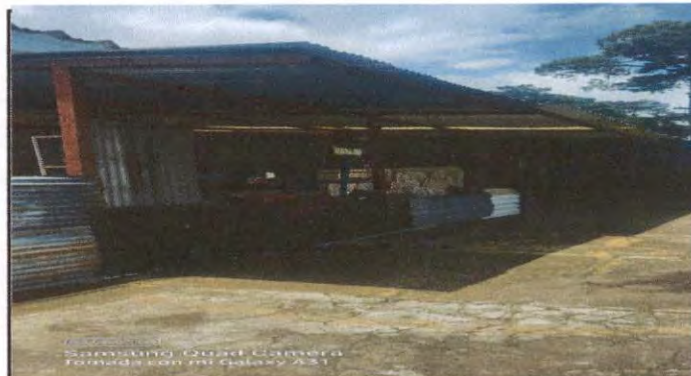
Reparación de tubo hg y malla galvanizada (servicio incluye: sustitución de malla deteriorada, lijado y pintura anticorrosiva) (área de taller)
