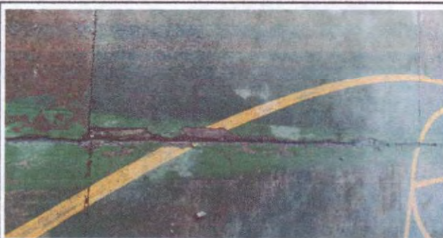
Foto 5: las grietas pueden generar problemas de humedad y hongos, afectando la salubridad del ámbito escolar.
