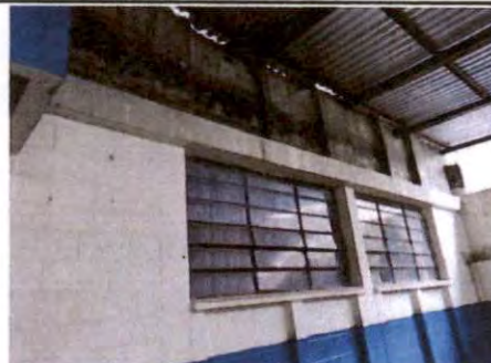
Foto 2: Sustrucción de capote de lámina para lámina troquelada.
