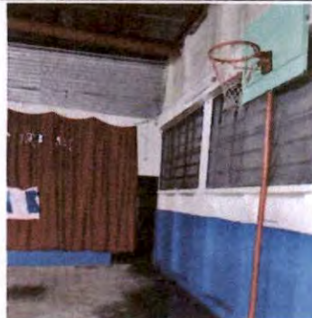
Foto 4: Reparación de muro perimetral de block
