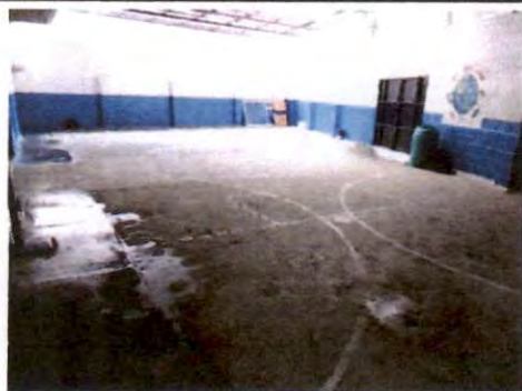
Foto 5: Reparación de planchas de concreto de patio
