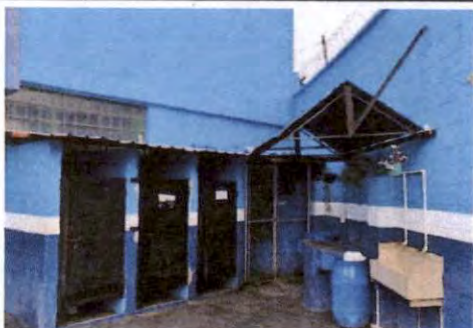
Foto 1: Sustrucción de lámina, por lámina troquelada aluzinc calibre 26
