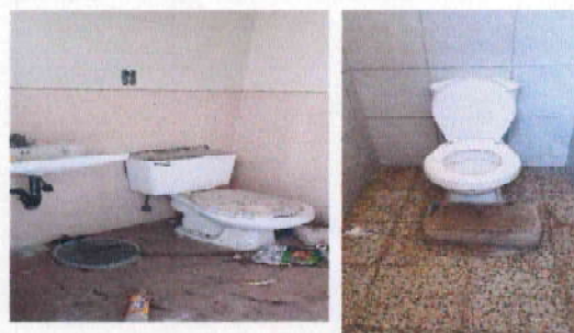
Foto 6: 10.2 Sustitución de inodoro en baños de niños línea baby Andes para pequeños, desmontar grandes e instalar pequeños.
