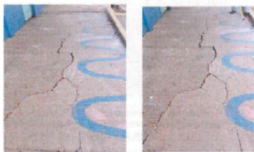
Foto 11: 16.1 Reparación de banqueta frente a aula.
