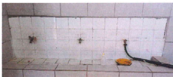
Foto 9: 13.1 Remozamiento de azulejos en lavamanos de baños de niños, solo en piso de canaly salpicadura oárea de chorros con azulejos de color blanco
