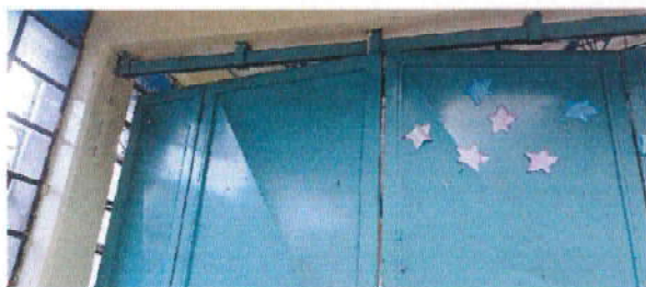
Foto 3: 4.1, 4.2 mantenimiento y reparación, engrasado de rodos en la parte superior y fijamiento de marco lateral de puertas plegables
