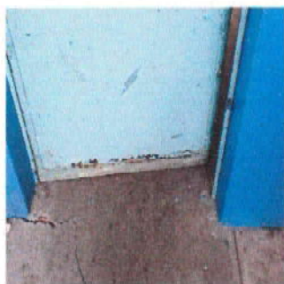
Foto 1: 4.1 Mantenimiento a puerta metálica de 4 aulas pintura del mismo color
