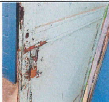
Foto 2: 4.2 Mantenimiento a puerta metálica cambio de chapa pintura del mismo color.
