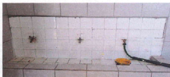
Foto 10: 14.13 Sustrucción de llaves de chorro, en lavamanos de baño de niños, incluye extracción de existentes y colocar nuevas marca grival pesadocnniple dde hg para ampliación
