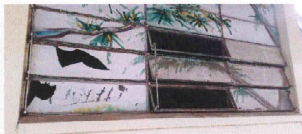
Foto 4: 5.5 Sustitución de vidrios claros de 5mm en ventanas
