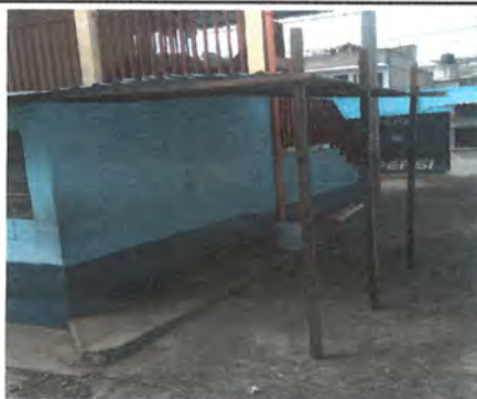
Foto 3: Sustitución de estructura de soporte y cubierta de lámina en pasillo y cocina
