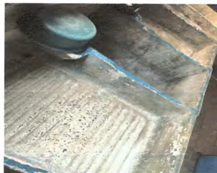
Foto 2: Traslado de pila a e insltación de drenajes y agua potable
