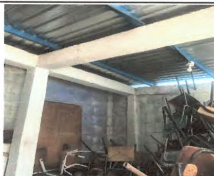
Foto 4: Mejoramiento de muros, e instalación de cielo falso en toda el area de la cocina
