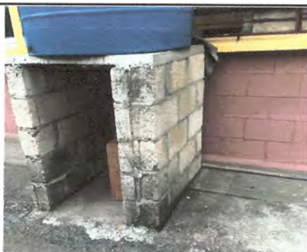
Foto 5: mejoramiento de las bases e instalación de un tinaco con capacidad para 400 litros de agua el cual abastecera la pila que estara en la cocina
