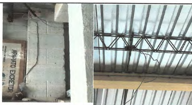
Foto 6: reparación e instalacion de nuevo cableado electrico y tomacorrientes nuevos, plafoneras y focos.
