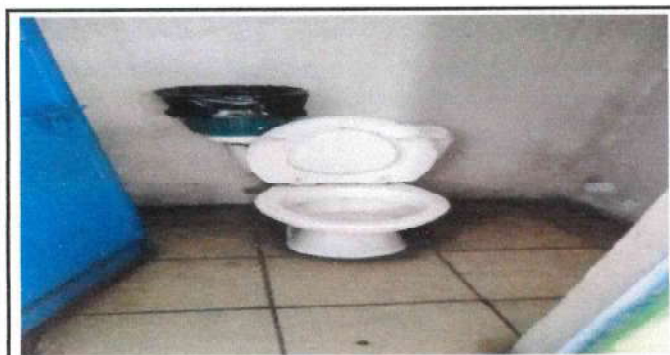
Cambio de Sanitarios
