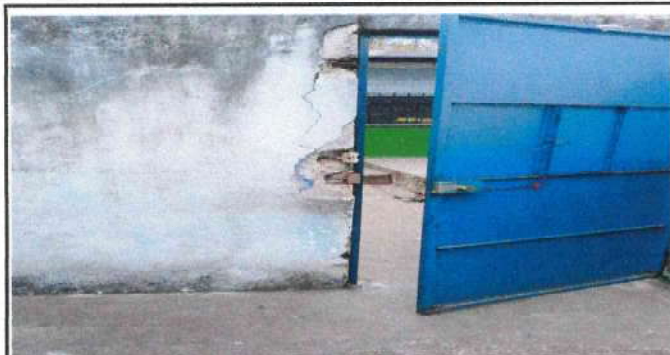
Reparacion y ajuste de marcos en puerta metalica en area de baño de niños
