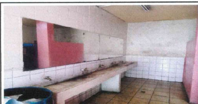
Retiro de azulejo existente y colocacion de nuevo azulejo en lavamanos en baño de niñas
