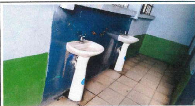
Cambio de Lavamanos por pila tipo artesanal con sus chorros
