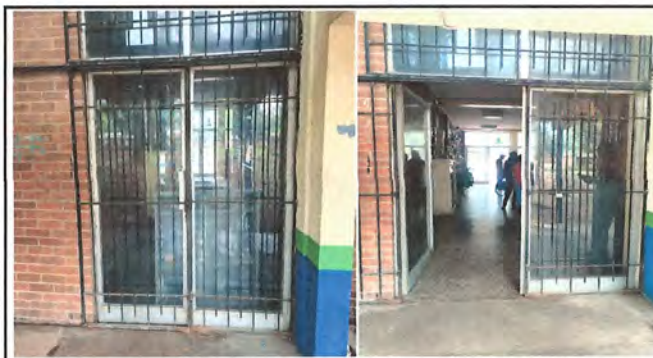
Foto 4: Mantenimiento puertas de rejas convertir de reja fija a reja abatible y sustitución de chapas
