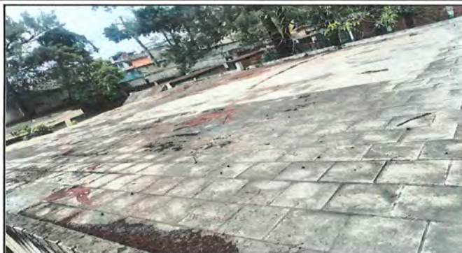
Foto 1: Impermeabilización de losa de 7 salones
