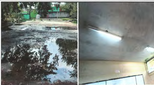
Foto 2: Nivelación e impermeabilización de losa 7 salones por filtración
