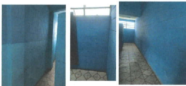
Foto 5: PINTURA EN MUROS INTERIORES DEL ÁREA DE SANITARIOS DE NIÑAS Y DE LOS NIÑOS EN EL PRIMER NIVEL Y EL ÁREA DE SANITARIOS DE NIÑAS Y NIÑOS DEL SEGUNDO NIVEL
