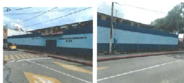
Foto 6: PINTURA EN MURO EXTERIOR
