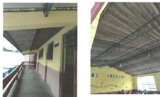
Foto 2: SUSTITUCION DE LAMINA, POR LAMINA TROQUETADA ALUZINC CALIBRE 26 (EN EL AULA DE TERCER GRADO) Y CAPOTE
