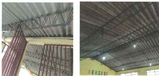
Foto 3: MANTENIMIENTO A ESTRUCTURA DE SOPORTE DE METAL (AULA DE TERCER GRADO Y GRADAS DEL II NIVEL)
