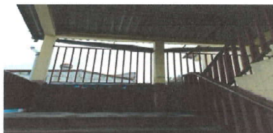
Foto 4: SUSTITUCIÓN DE CANAL DE METAL (FRENTE A GRADAS DEL II NIVEL)
