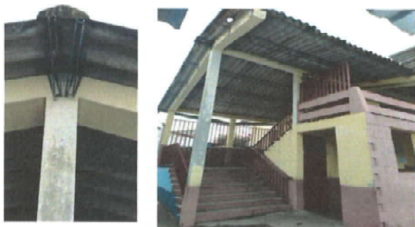
Foto 1: SUSTITUCION DE LAMINA, POR LAMINA TROQUETADA ALUZINC CALIBRE 26 (EN LAS GRADAS PARA EL II NIVEL) Y CAPOTE
