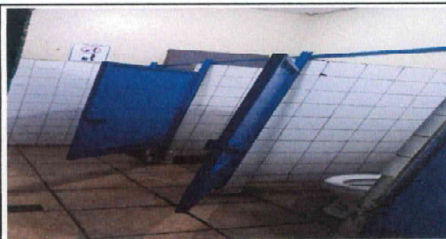
Foto 4: Reparacion y ajustes puerta de baños de varones
