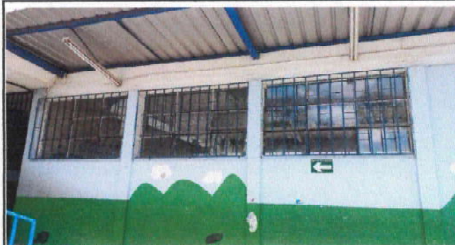
Foto 2: Cambio de ventanas por ventanas corredizas tipo PVC de 5mm
