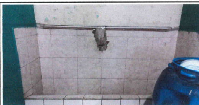
Foto 5: reparacion de sistema de agua migitorio en baño de varones
