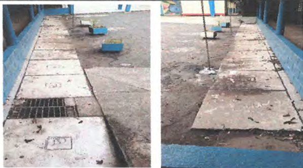
Foto 3: 8 Limpieza mantenimiento de cuneta parte baja de patio de astas, incluye mover y colocación de planchas de concreto para efectuar dicha limpieza
