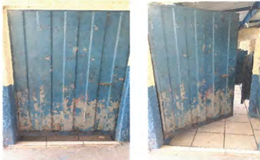
Foto1: 4.1 Mantenimiento de puerta metálica en sanitario de niñas, como lo es lijado y pintura de aceite, cambio de chapa existente en mal estado por una marca vale.
