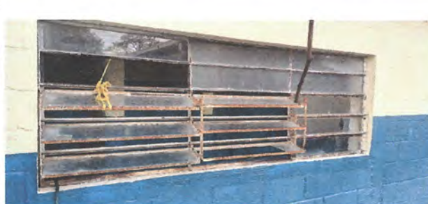
Foto 2: 5.1 Sustitución de ventana en sanitario de niñas, con barrotes de tubo cuadrado de 1"x1" pintado de color azul
