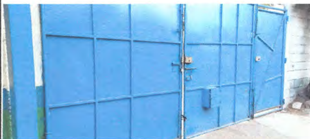
Foto 5: 12.1 Desmontar portón existente en mal estado + instalación de portón corredizo (# 1), con lámina 3/64", tubo cuadrado de 1 1/2" chapa 18, con rieles y rodos de cojinete en la parte inferior
