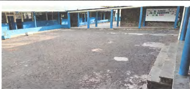
Foto 9: 16.1 Reparación de piso de patio con fundición de concreto de 4-5 cm de espesor con cernido semi fino como acabado final, (solo área azfaltada)
