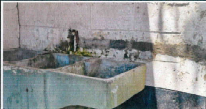
Foto 8: Cambio de línea de agua potable en pila
