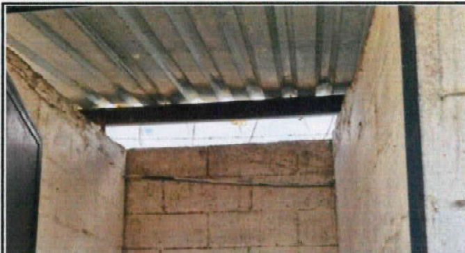
Foto 14: Instalación de lámina para sellar parte superior de baño de niñas
