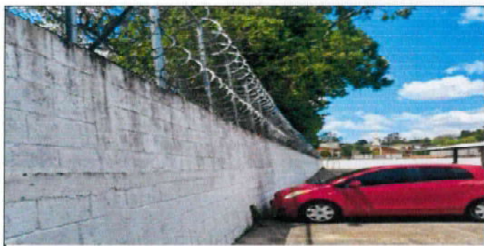
Foto 11: Limpieza de superficie de muro perimetral
