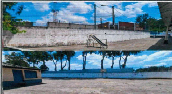
Foto 2: Pintura en muros
