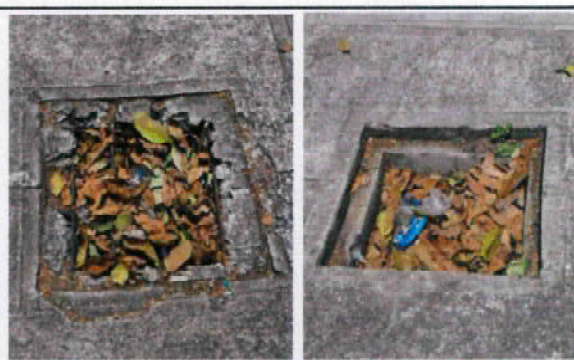
Foto 6: Mantenimiento de reposaderas de patio
