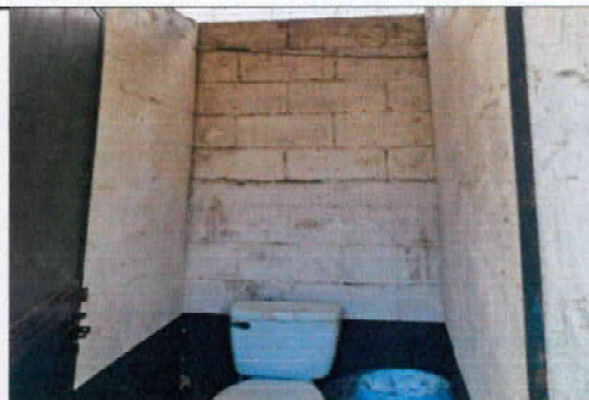
Foto 4: Instalación de azulejo en baño de niñas
