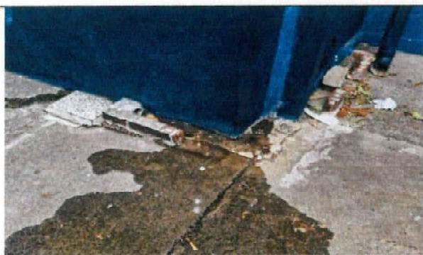
Foto 5: reparacion de fuga en drenaje de plla
