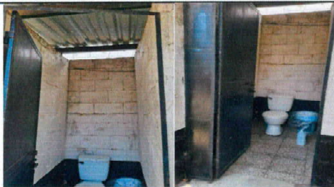
Foto1: Remozamiento de puerta de metal
