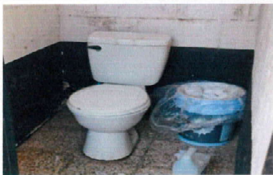
Foto3: Cambio de sanitario
