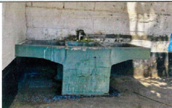
Foto 13: Cambio de pila
