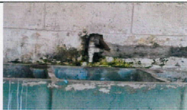
Foto 10: Cambio de chorro en pila
