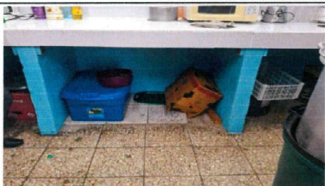
Foto 15: Fabricación de entrepaños de concreto a mueble de cocina
