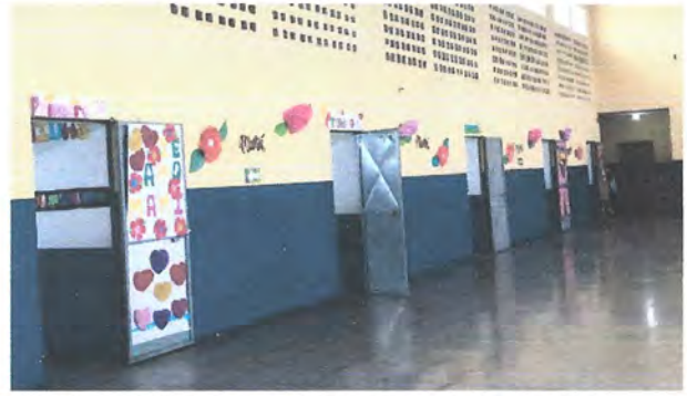
Foto 2: Mantenimiento, lijado, cepillado y aplicación de pintura en las puertas de las aulas.
