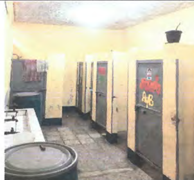
Foto 4: Colocación de azulejo en todas las paredes, pintura en muros, mantenimiento y pintura en 8 puertas, sustitución de lámpas led.
