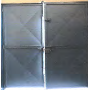
Foto 1: Mantenimiento: Lijado, cepillado, pintura, enderezado y cambio de chapa (2 puertas de doble hoja)
