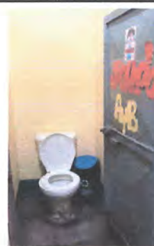
Foto 6: Remoción e instalación de sanitarios.
