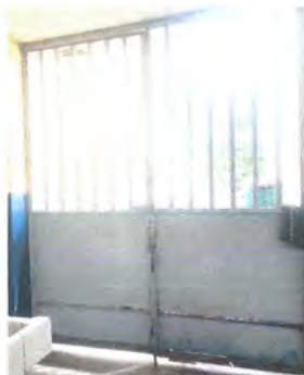
Foto 3: Mantenimiento: Lijado, cepillado, pintura, enderezado y cambio de chapa, cambio de paneles y tubo inferior.
