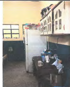
Foto 8: Fabricación , Fundición e Instalación de Top Para Cocina, Material Cemento, acabados alisado con Monocapa, Incluye Puertas De Madera. Instalación De Azulejo en Muebles de Cocina.
