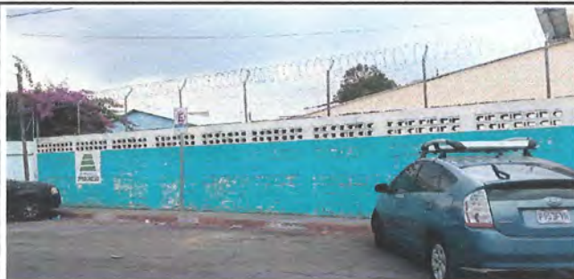
Foto 11: Pintura En Muros Exteriores (frente escuela)
