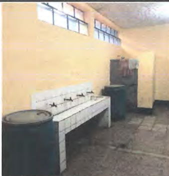
Foto 5: Remoción e instalación de azulejo en lavamanos.
