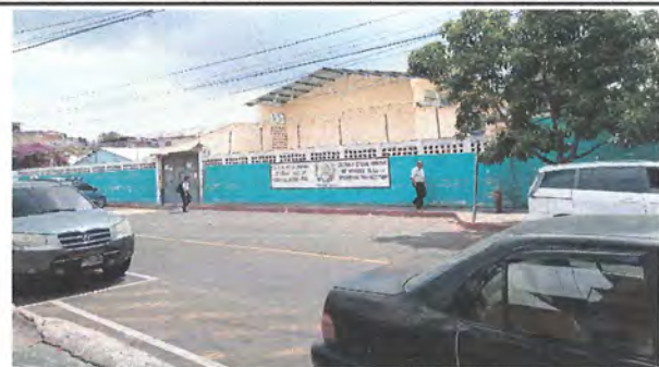
Foto 12: Pintura En Muros Exteriores (frente escuela)
