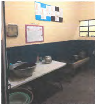
Foto 7: Fabricación , Fundición e Instalación de Top Para Cocina, Material Cemento, acabados alisado con Monocapa, Incluye Puertas De Madera. Instalación De Azulejo en Muebles de Cocina
