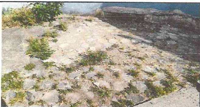
REMOZAMIENTO EN AREA DE PATIO DE ADOQUIN
