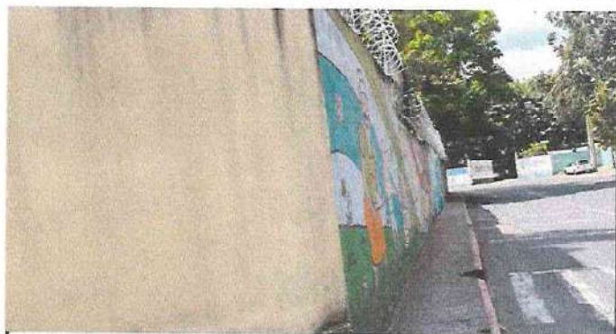
PINTURA EN MURO EXTERIOR
