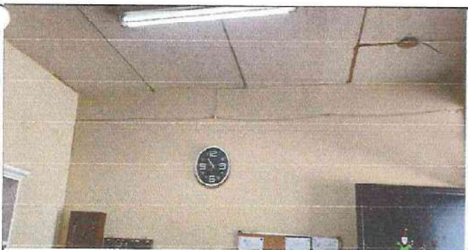
PINTURA EN AREA DE DIRECCION TECHO Y PAREDES
