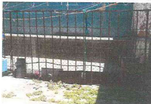
Foto 2: SUSTITUCION REJAS POR PORTON DE METAL CON PUERTA
