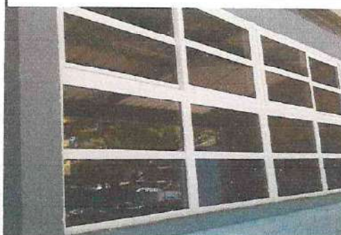
Foto 4: sUMINISTRO E INSTALACION DE BALCONES , AULAS SEGUNDO NIVEL 4.10 X 1.80
