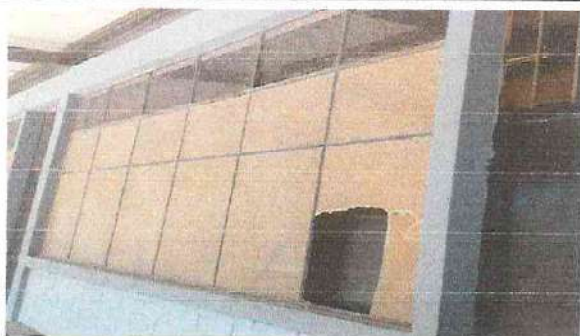
Foto 7: SUMINISTRO E INSTALACION DE VENTANALES PVC SEGUNDO NIVEL 4.10MTS X 1.80
