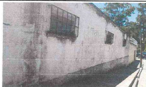
Foto 8: PINTURA DE MURO PERIMETRAL PARTE EXTERIOR DEL ESTABLECIMIENTO 214 M2
