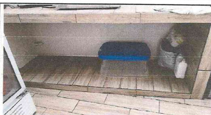
INSTALACION DE ENTREPAÑO DE CONCRETO DE 1.20 XO.70 INCLUYE INSTALACION DE AZULEJO.
