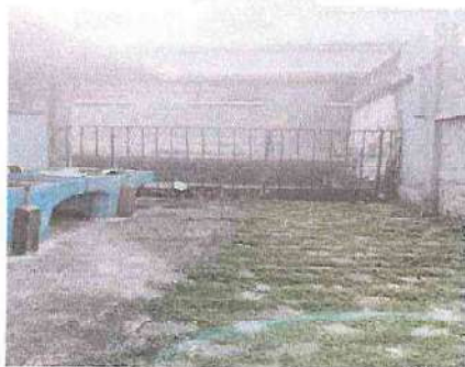
SUSTITUCION DE REJAS POR PORTON EN PATIO INTERIOR
