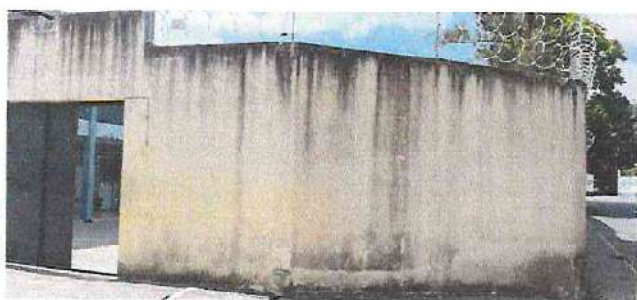
PINTURA EN MURO EXTERIOR
