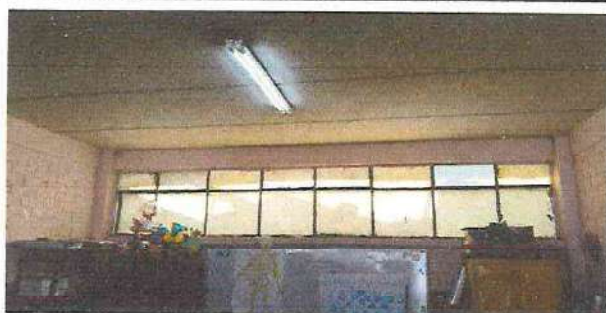
FOTO 3: SUMINISTRO E INSTALACION DE VENTANALES TIPO SIFON PRIMER NIVEL 1MT. X 5.06MTS.
