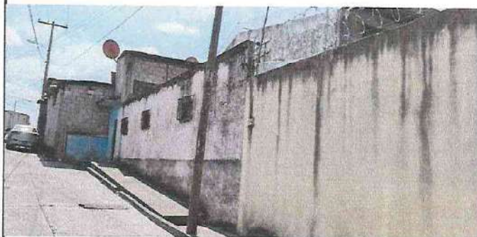
PINTURA EN MURO EXTERIOR
