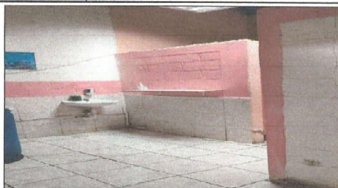
Foto 2: Pintura en muros de sanitario de maestros.
