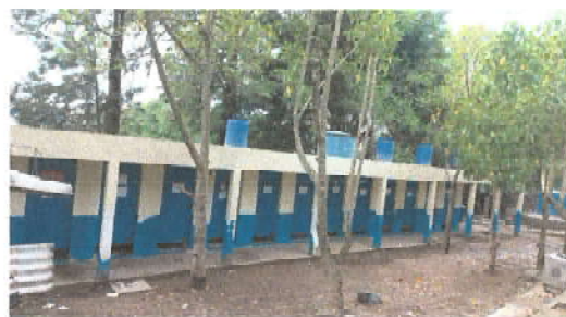
Foto 4: Depositos de agua en area de sanitarios de niñas, se instalaran 3 tinacos
