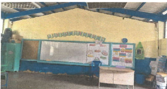
Foto 5: Muros perimetrales, reparacion de muro perimetral de madera sera remozado por uno de durock con sus bases de metal.
