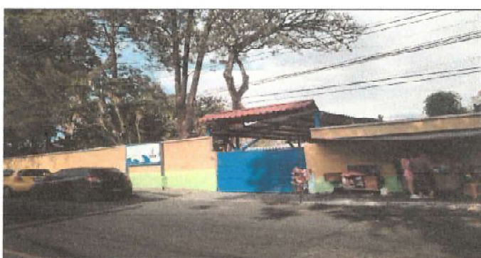
Foto 6: Pintura en muros exteriores de escuela.
