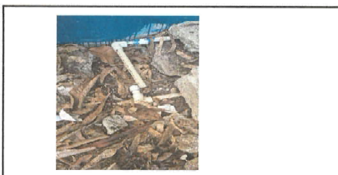
Foto 10: Instalación de tubería para agua potable para tinacos
