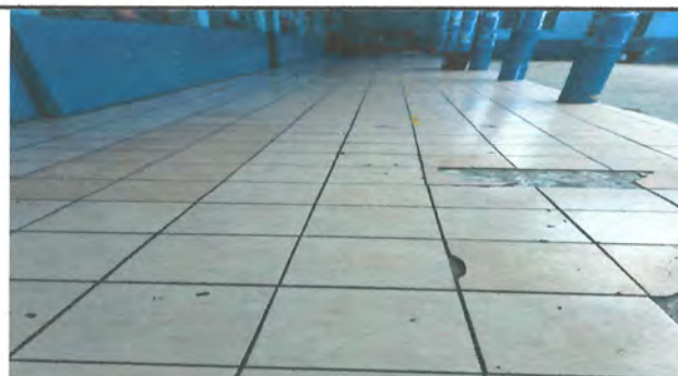
FOTO 4: SUMINISTRO E INSTALCIÓN DE PISO CERAMICO
