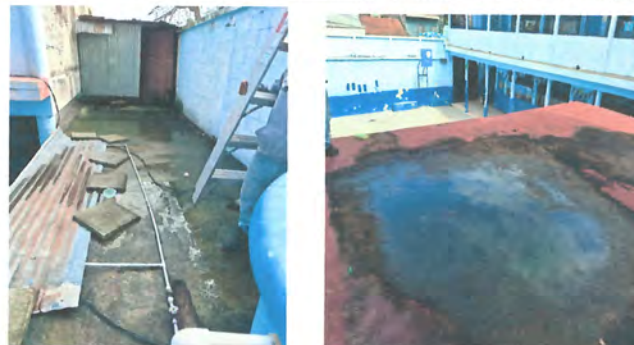
Foto 2: IMPERMEABILIZACIÓN DE AREA DEL SEGUNDO NIVEL
