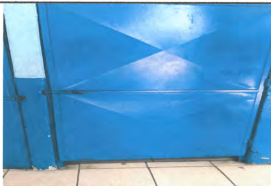
FOTO: 3 PINTURA DE PUERTAS DE LOS BAÑOS
