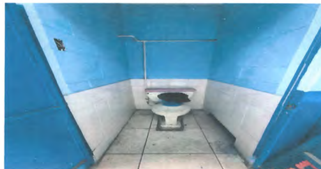
FOTO 6: SUMINISTRO E INSTALCIÓN DE INODOROS
