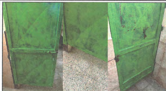
FOTO 1: Sustrución de puertas de baño de niñas
