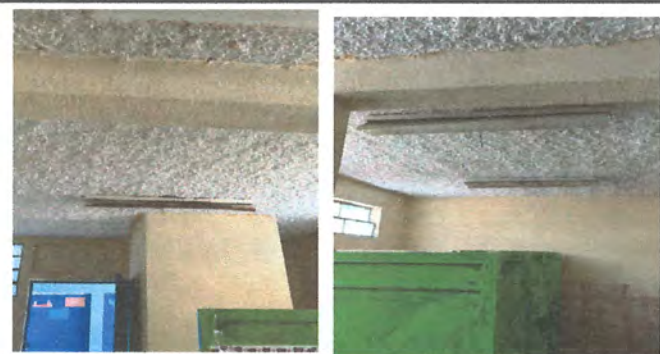
FOTO 11: Instalacion de lamparas led con interruptor
