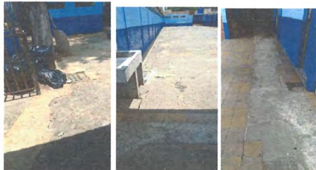
FOTO 7: CONSTRUIR DRENAJE DE 6"
