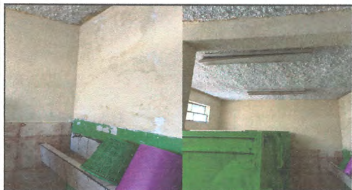
FOTO 3: Pintura en muros
