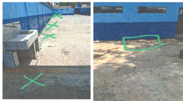
FOTO 8: CONSTRUCCIÓN DE CAJAS DE REGISTRO
