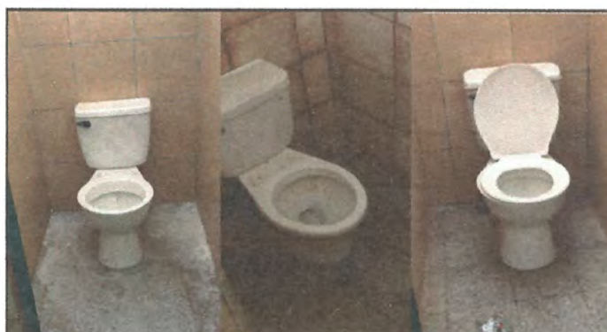
FOTO 4: Sustrución de sanitarios
