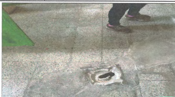
FOTO 2: Sustrución de piso en baño de niñas
