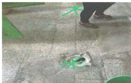
FOTO 10: INSTALACION DE REPOSADERAS
