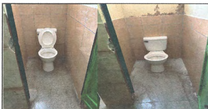
FOTO 6: Sustrución de azulejo
