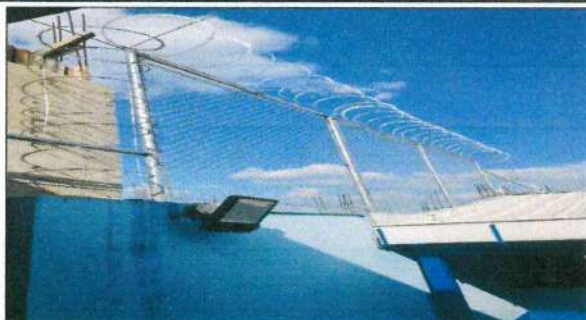
Foto 7: Fabricación e instalación de malla perimetral en área de aulas en riesgo.
