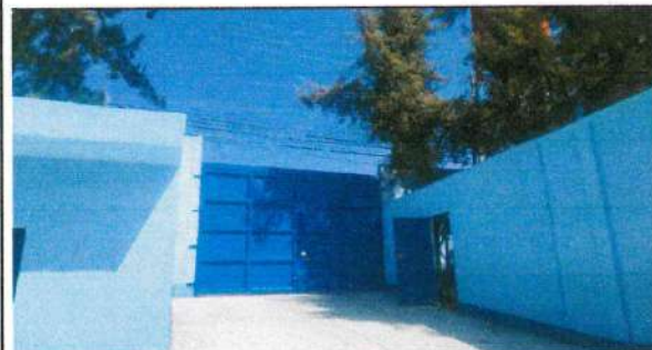
Foto 3: Remozamiento de porton, enderezado, pintado y cambio de chapa.
