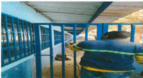
Foto 9: Reparación de puerta que da hacia bomba hidroneumática.
