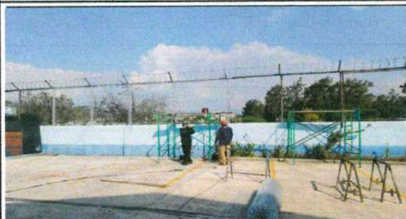
Foto 1: Cambio de malla de 2x2 de abertura calibre 12 en 18 áreas afectadas.
