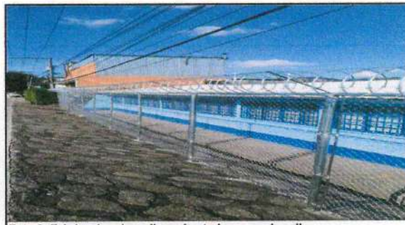
Foto 6: Fabricacion de malla perimetral en area de calle.
