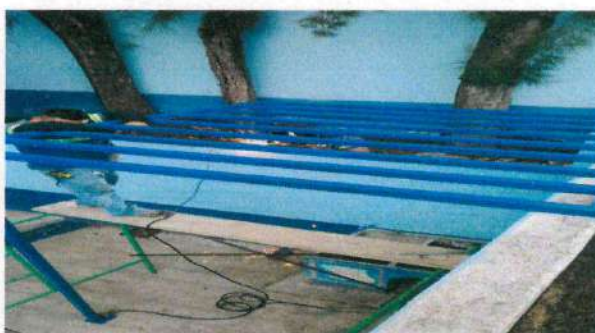
Foto 4: Estructura de metal de 2x2 para colocar tinaco de agua potable.
