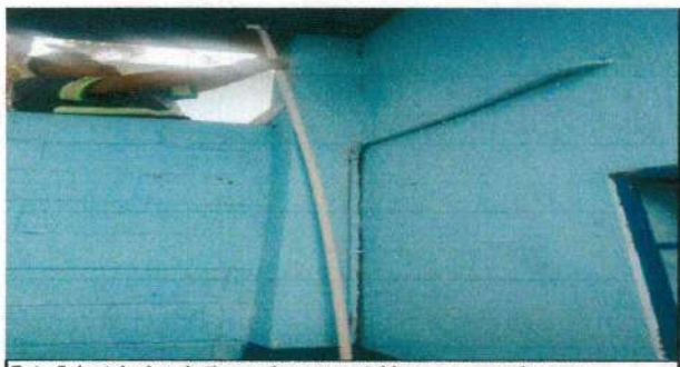
Foto 5: Instalacion de tinaco de agua potable con accesorios para distrubucion de agua en cocina.
