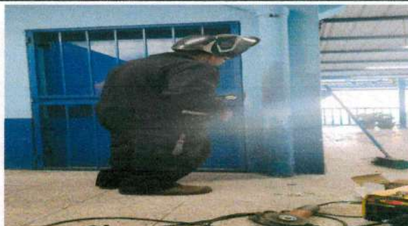
Foto 8: Cambio de chapa de direccion.
