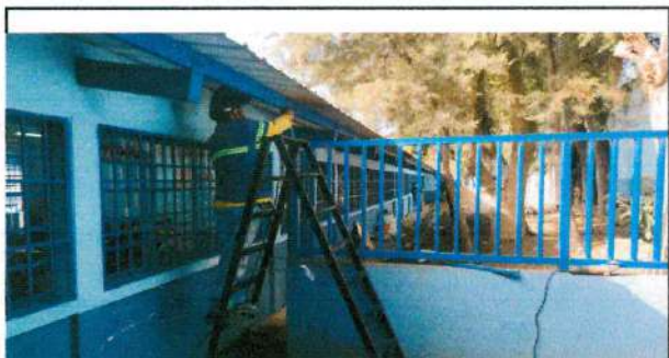
Foto 9: Reparacion de puerta que da hacia bomba hidroneumatica.
