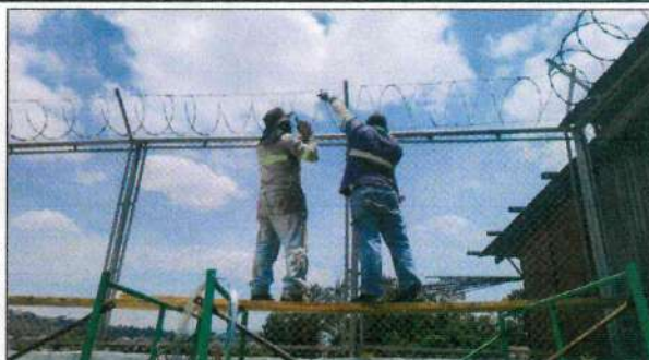
Foto 2: Cambio de razor en áreas dañadas de escuela 70 mts lineales
