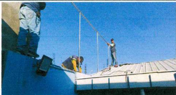
Foto 7: Fabricacion e instalacion de malla perimetral en area de aulas en riesgo.
