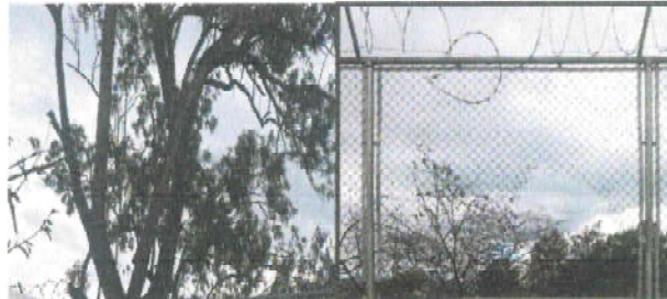
Foto 2: Cambio de Razor 70 metros por deterioro del incendio
