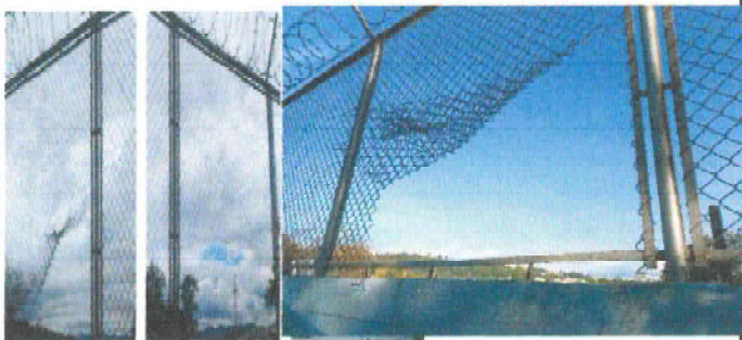
Foto1:SUSTITUCIÓN DE MALLA POR EL INCENDIO
