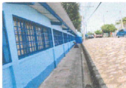
Foto 4: Área de calle colocar nuevas mallas con estructuras de metal de protección de aulas de primero y segundo prim hacia calle
