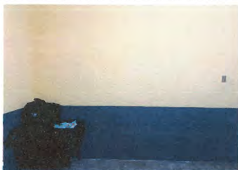
foto5: Demolición de 12 metros de pared de cemento y extracción de residuos
