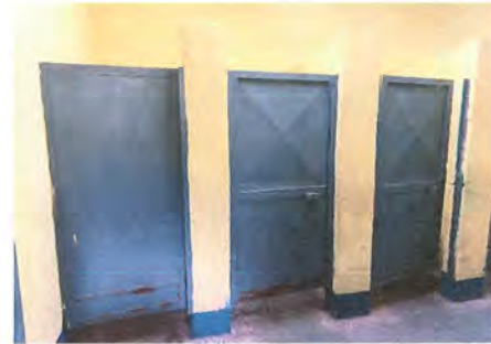
Foto2: Lijado, limpieza y pintura de puertas sanitarios.
