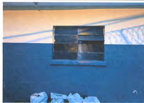
foto 2: Abertura de ventana para colocar puertas de metal abatibles para despacho de alimentos.
