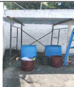
Foto 6: Instalación de estructura portante de metal de tubo galvanizado de 3X3 pulgadas costaneras de 3X2 y lamina troquelada calibre 26
