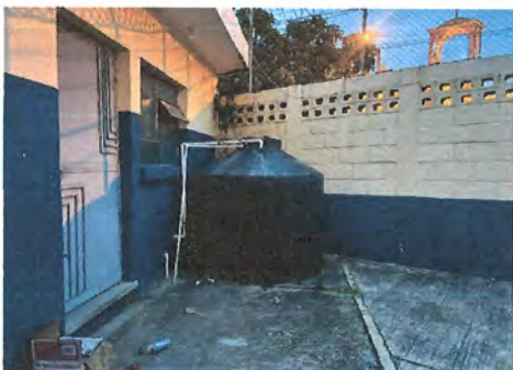
foto 1: Instalación de malla galvanizada con tubo y priva cinta con puertas abatibles malla y tubo, para cercar roto plas.
