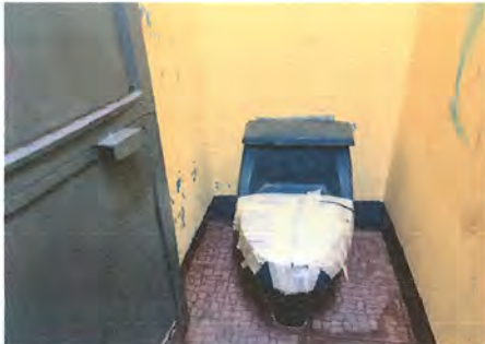
Foto3: Desinstalación sanitario dañado e Instalación de inodoro con sus accesorios.
