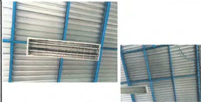
Foto1: Sustitución de tubo LED 18W, con utilización de andamio por la altura del techo en aulas a la derecha entrando por dirección jornada vespertina.
