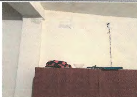
foto4: Apertura y tallado para ventana.
