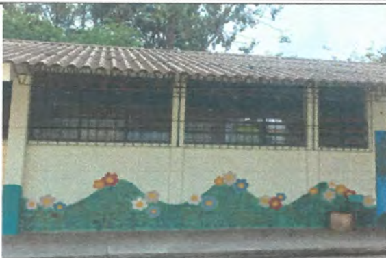
FOTO 1: Cambio de duralita por cubierta de lamina
