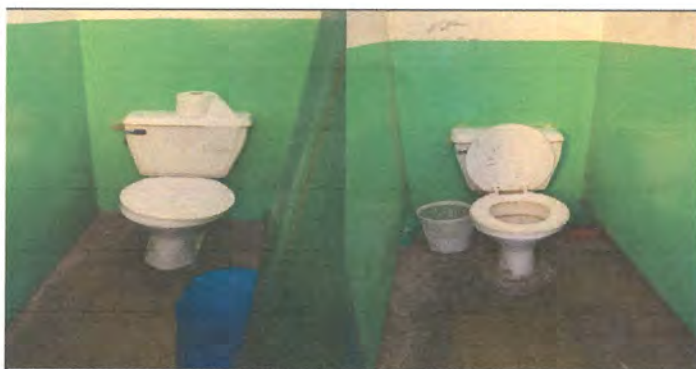
FOTO 5: Cambio de sanitarios baño maestros
