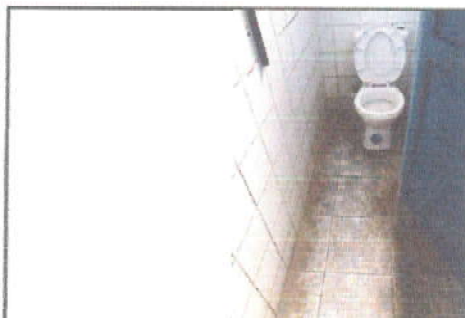
Foto 7: 6.8 Sustitucion de piso ceramico 22 m²
