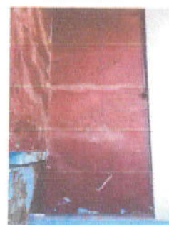
Foto 10: 15.01 REPARACION DE MURO 2.02 m²
