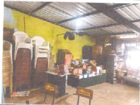
Foto 34: 9.1 Pintura en muros exteriores e interiores 671 m²
