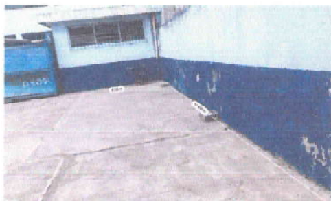
Foto 15: 21.4 Sellado de Grietas y fisuras en muro 34.82 ML
