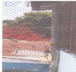
Foto 14: 7.4 Sustitución de bajada de agua pluvial de metal por tubo pvc 3" 6 ML
