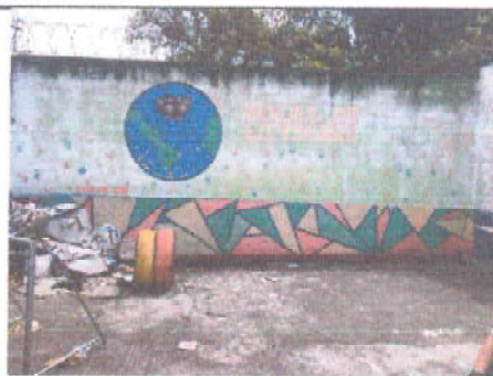
Foto 19: 9.1 Pintura en muros exteriores e interiores 671 m²
