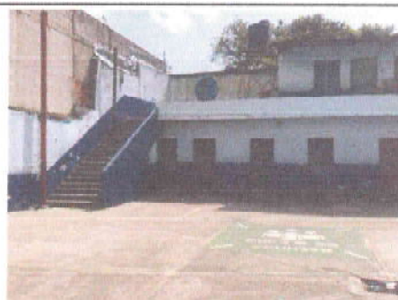
Foto 18: 9.1 Pintura en muros exteriores e interiores 671 m²
