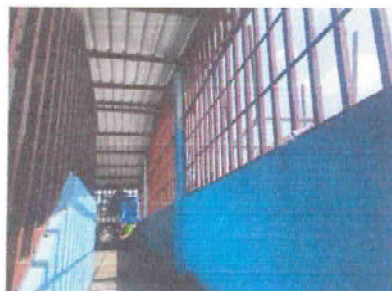
Foto 20: 11.1 MANTENIMIENTO A BARANDA DE METAL 34 m²
