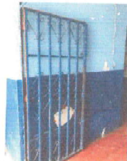
Foto 36: 4.1 Mantenimiento a estructura (lijado, aplicación de pintura) 23 UNIDADES
