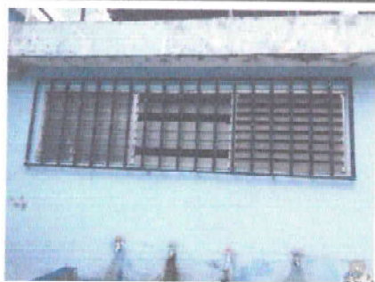
Foto 42: 5.7 MANTENIMIENTO BALCONES DE METAL 9 UNIDADES CON 13.39 m²
