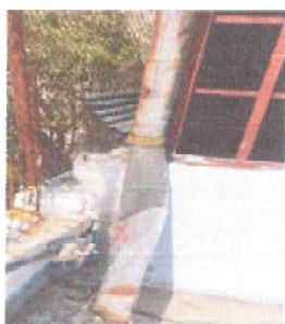
Foto 13: 7.4 Sustitución de bajada de agua pluvial de metal por tubo pvc 3" 6ML
