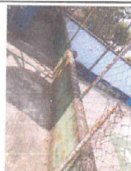
Foto 41: 15.3 REPARACION DE MALLA GALVANIZADA 32 m²
