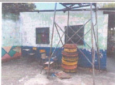
Foto 17: 9.1 Pintura en muros exteriores e interiores 671 m²
