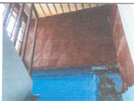
Foto 9: 15.1 REPARACION MURO 4.03 m²
