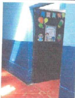
Foto 37: 4.1 Mantenimiento a estructura (lijado, aplicación de pintura) 23 UNIDADES
