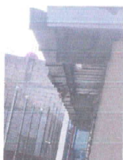
Foto 11: 6.8 SUSTITUCION DE CANAL DE METAL 20 ML
