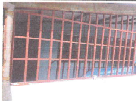
Foto 21: 11.1 MANTENIMIENTO A BARANDA DE METAL 34 m²
