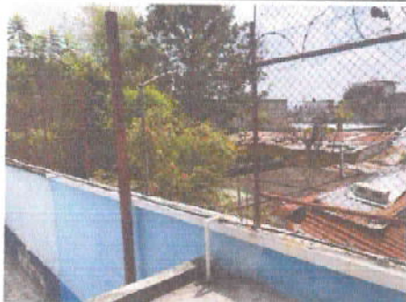
Foto 40: 15.3 REPARACION DE MALLA GALVANIZADA 32 m²
