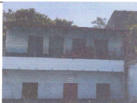
Foto 16: 9.1 Pintura en muros exteriores e interiores 671 m²
