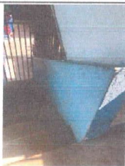
Foto 18: 9.1 Pintura en muros exteriores e interiores 671 m²
