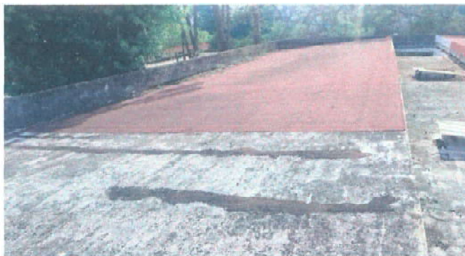
Foto 4: Impermeabilización de distintas áreas de terraza
