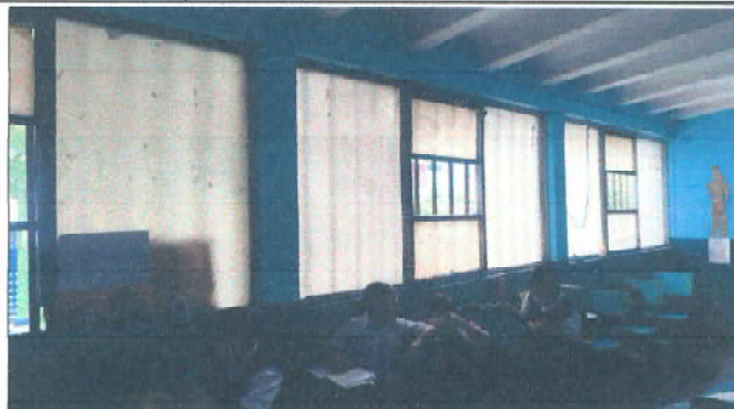
Foto 2: Sustitución de ventanas de aluminio por PVC mas vidrio
