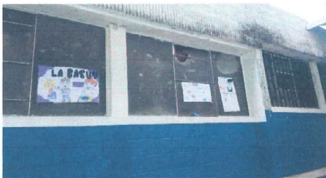
Foto 3: Instalación de balcón de metal en salon de maestros.
