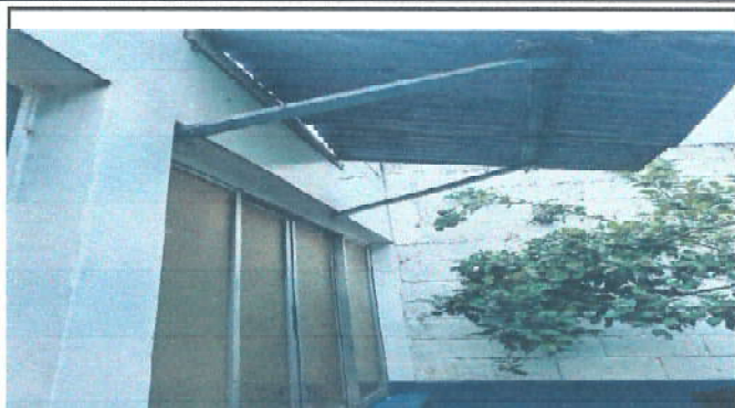
Foto 1: Sustitución de cubierta de lámina y estructura de soporte en área de cocina.
