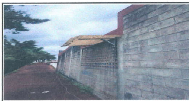
Foto 6: Sustitución de lámina y estructura de soporte para evitar ingreso de agua llovida.
