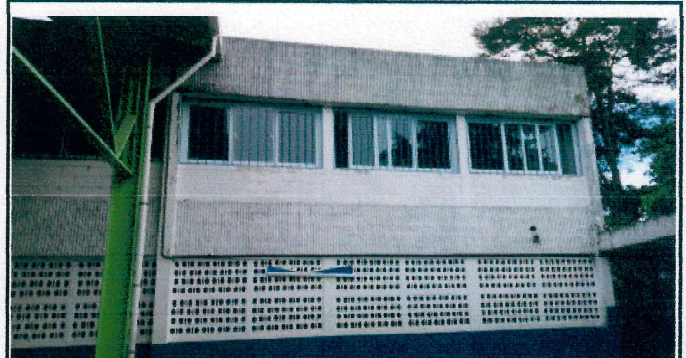
Foto 2: Suministro e instalación de balcones de metal (área de salones de segundo nivel con hierro de 1/2 cuadrado de medidas de 1.37 mts de alto por 2.60 mts de ancho)
