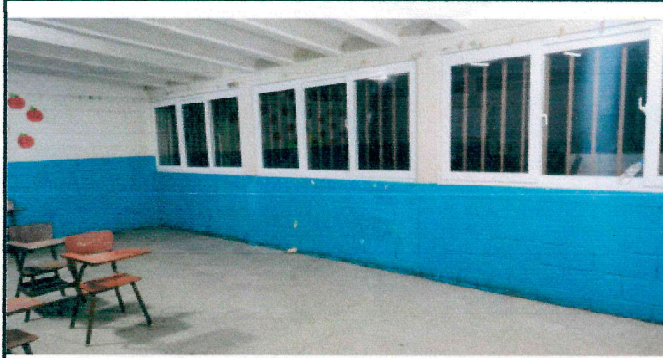
Foto 1: Sustitución de ventana por ventana tipo PVC blanco y vidrio transparente de 5 mm de grosor con sus cerrojos, dando mts cuadrados 63.7 mts cuadrados ( ventanal 2 en cocina, 3 en primero A, 3 en primero B, 2 en segundo A, 3 en tercero A, 3 en cuarto A, 3 en cuarto B y 3 en sexto)
