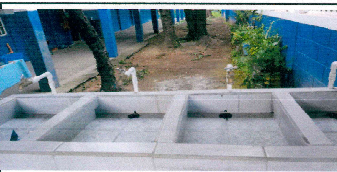
Foto 5: Sustitución lavamanos (en patio, fundiciones de Bases de concreto e instalación de 4 chorros y 4 drenajes para los mismos todo con sus acabados correspondientes.)
