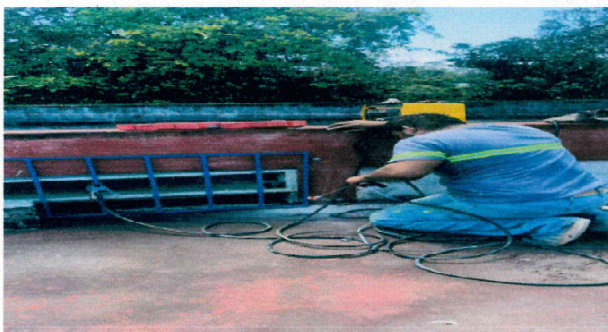
Foto 3: Sustitución de balcones de metal (en área de dirección de medidas de 1.90 mts por 0.55 mts de alto con hierro de 1/2 cuadrado)
