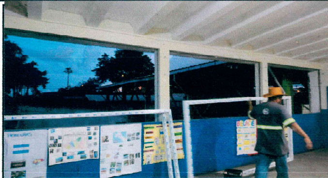
Foto 1: Sustitución de ventan por ventana tipo PVC blanco y vidrio transparente de 5 mm de grosor con sus cerrojos, dando mts cuadrados 63.7 mts cuadrados ( ventanal 2 en cocina, 3 en primero A, 3 en primero B, 2 en segundo A, 3 en tercero A, 3 en cuarto A, 3 en cuarto B y 3 en sexto)
