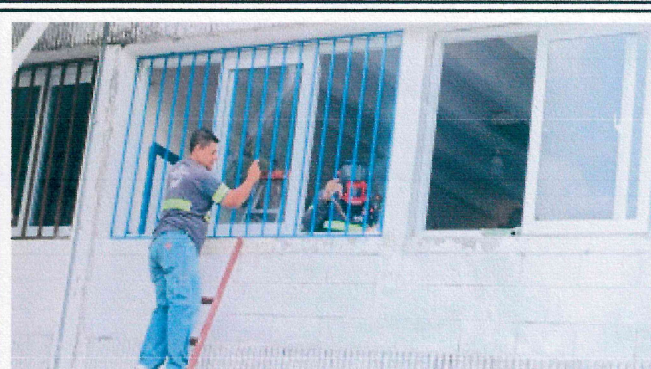
Foto 2: Suministro e instalación de balcones de metal (área de salones de segundo nivel con hierro de 1/2 cuadrado de medidas de 1.37 mts de alto por 2.60 mts de ancho)
