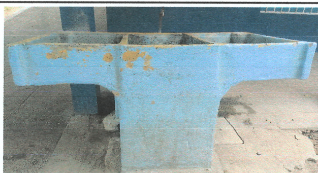
Foto 5: Sustitución de pila (en patio, fundiciones de Bases e instalación de 4 chorros y 4 drenajes para los mismos todo con sus acabados correspondientes.)
