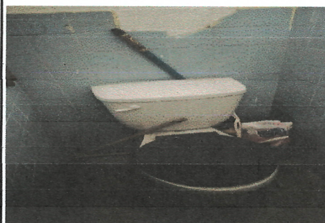
Foto 4: Sustitución de accesorios inodoro (arbolito, flote, empaque de tanque-taza para wc con tornillos, manija frontal, sapito). Sanitario de maestros
