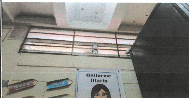
Foto 3: Sustitución de balcones de metal (en área de dirección de medidas de 1.90 mts por 0.55 mts de alto con hierro de 1/2 cuadrado)
