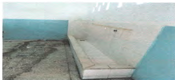
Foto 11: 10.5 Demolición y sustitución de migitorio baño de niños
