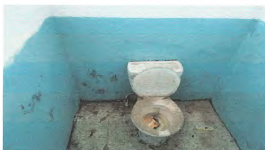
Foto 9: 10.3 Sustición de inodoros
