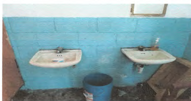
Foto 10: 10.5 Sustitución de lavamanos baño de maestros , 13 . Reparación y Sustición de azulejos para baño de maestros
