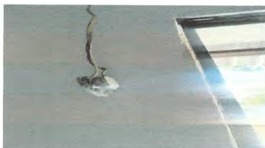
Foto 15: 17.3 Sustitución de apagadores dobles baño de niños
