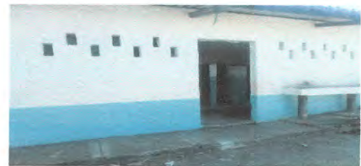
Foto 6: 9.1 Pintura de muros exterior de agua y aceite
