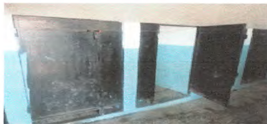
Foto 8: 10.1 Mantenimiento a estructura de puertas y estructura metalica servicio sanitarios baño de niños
