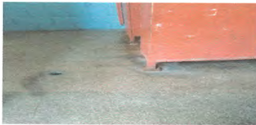
Foto 5: 6.8 Sustitución de piso cerámico antideslizante
