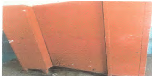
Foto 17: 19.3 Fabricación e instalación de puertas de metal en módulos de baños de maestros.
