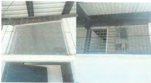
Foto 3: 5.1 Mantenimiento de estructura de metal
