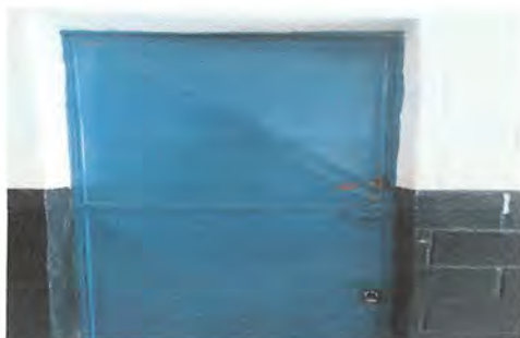
Foto19: 19.3 Fabricación e Instalación de puerta de metal dirección
