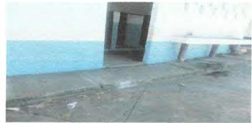
Foto 4: 6.5 Sustitución de torta de concreto por loza patio con electromalla
