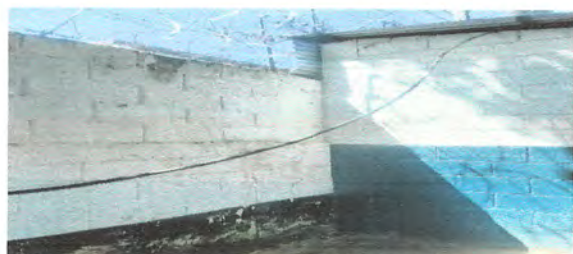
Foto 13: 17.3 Sustitución de tubería eléctrica cableado
