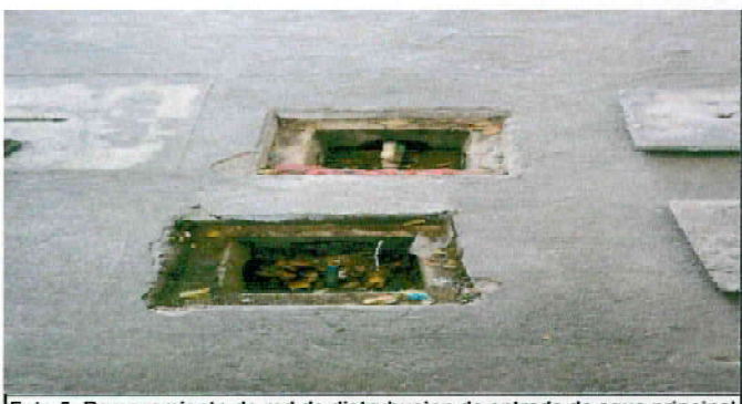
Foto 5: Remozamiento de red de distrubcion de entrada de agua principal
