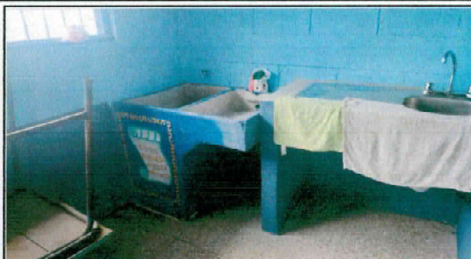
Foto 8: Cambio de pila en area de cocina.
