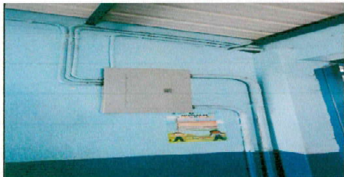
Foto 11: Instalación de tablero para bomba hidroneumatica, con su cable triplex.
