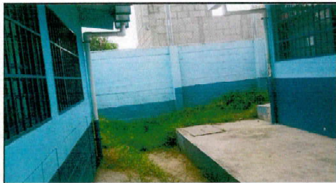
Foto 9: Instalación de malla con tubería de 2 redonda en area de primero.
