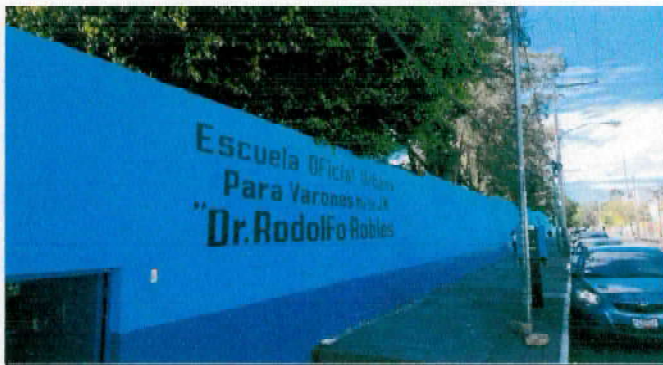
Foto 4: Instalacion de razor en todo el frente de escuela.
