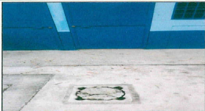
Foto 1: Cambio de 12 tapaderas de concreto quebradas por unas de metal en distintas áreas de escuela.
