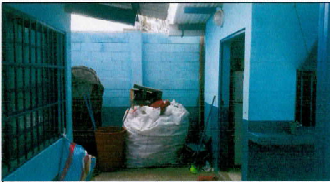
Foto 10: Fabricación e instalación de malla con tubería de 2 y puerta de ingreso en area de tienda.
