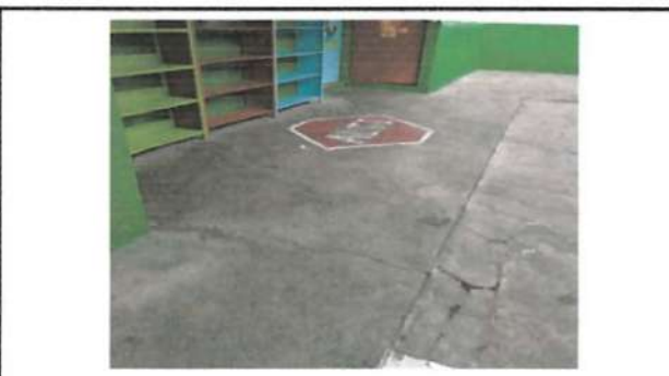
FOTO 10: Instalación de piso de granito en corredor de 1er. Nivel
