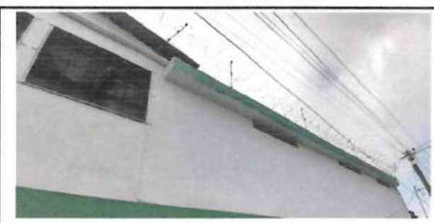
FOTO 12: Mantenimiento y limpieza de canal exterior de concreto del 2do. Nivel.
