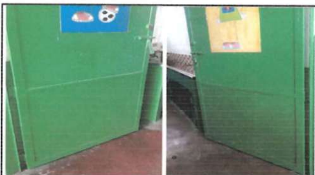
FOTO 3: Remozamiento de puertas de metal, modificar medida por instalación de piso.
