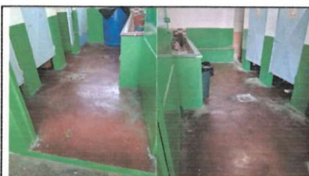
FOTO 4: Instalacion de piso de granito en baños de niñas y de niños.
