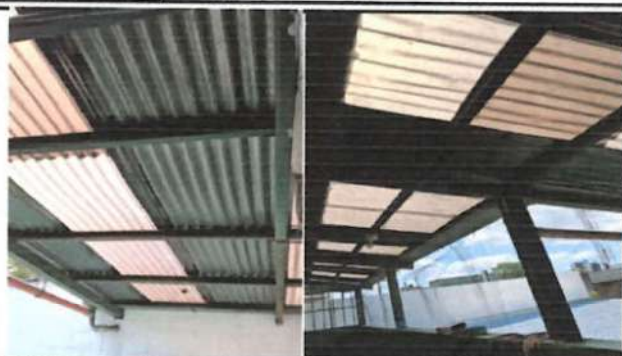
FOTO 1: Cambio de lamina en techo de 2do nivel area pasillos, arriba de gradas.
