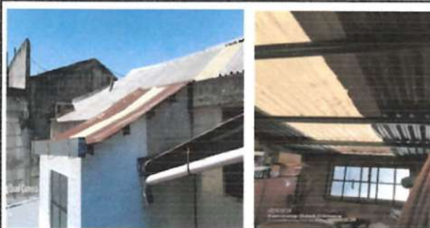
FOTO 8: Sustitución de lámina por lámina troquelada Alzincalibre 26 área de bodega 2do. Nivel.
