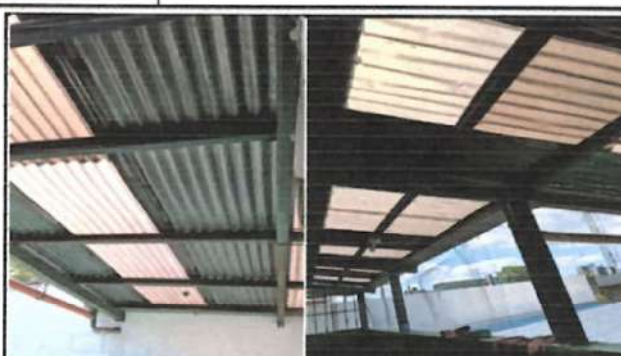
FOTO 2: Mantenimiento a estructura de techo limpieza, lijado y aplicación de pintura anticorrosiva.
