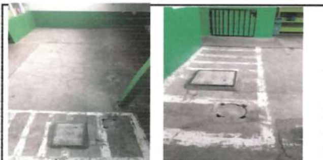
FOTO 11: Nivelación de área para flujo pluvial, elevación de tapadera de sistema.
