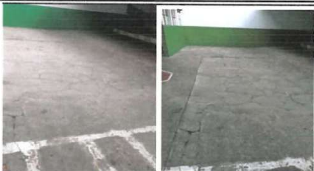
FOTO 7: Fundición de losa de patio de 8 cm.
