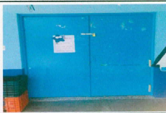
Foto2: Sustitucion de puerta por puerta doble de metal
