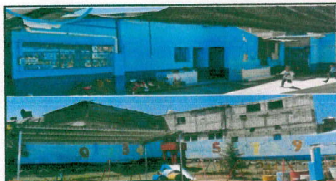
FOTO 17: Complemento fotos pintura en muros
