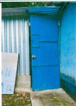
Foto 1: Remozado y modificación de puerta de metal para bodeguita
