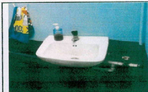
FOTO 14: Instalación de lavamanos en baño de maestros
