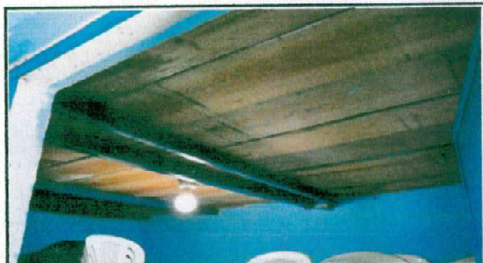
FOTO 13: Desmontar estructura de piso elevado y construcción de piso elevado nuevo en área de cocina
