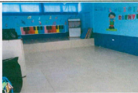
FOTO 4: Cambio de sisa en piso ceramico existente aula escenario
