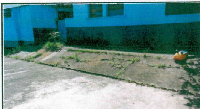
FOTO 15: Demolición de losa inclinada para construir gradas de acceso a patio posterior
