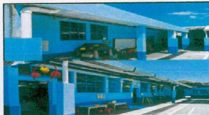
FOTO 16: Complemento fotos pintura en muros
