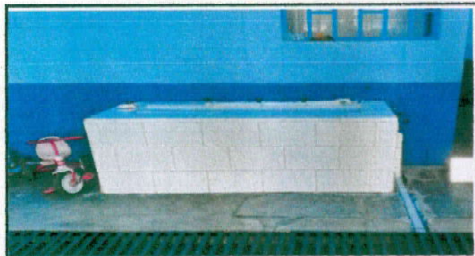
FOTO 9: Reparación de lavamanos comunitario
