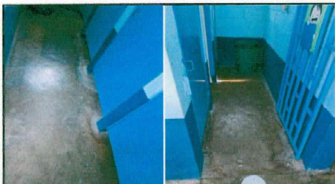
FOTO 3: Instalacion de piso ceramico en area de baños alumnos.
