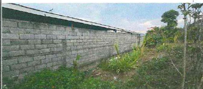
Foto1: Excavación de 2.50 m de profundidad, impermeabilización y aplicación de ensvietado y cernido en muro.
