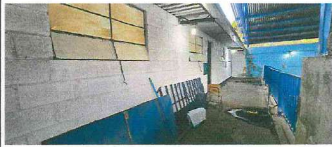
Foto 6: Suministro y aplicación de ensvietado y repello en aulas de segundo nivel.
