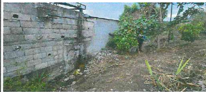
Foto 2: Mantenimiento e impermeabilización en muro en parte de atrás del edificio escolar.
