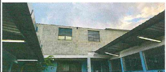
Foto 5: Suministro e instalación de lámina troquelada calibre 26 en aulas de segundo nivel.
