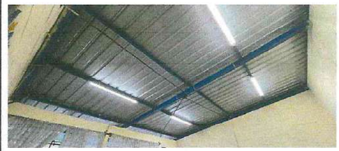
Foto 4: Reparación y mantenimiento decubierta de lámina por filtración en subdirección.
