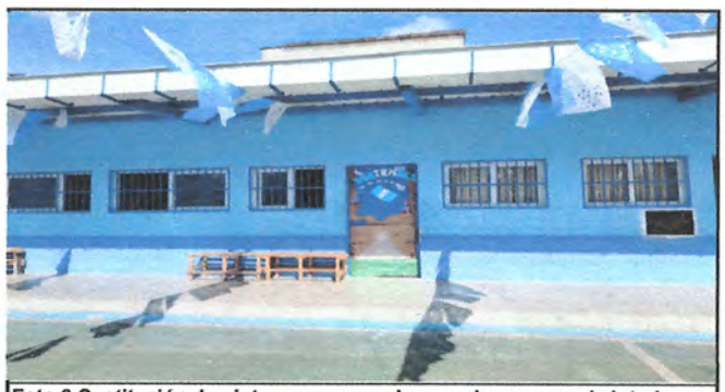
Foto 6: Sustrución de pintura en muros de escuelas en area de interior, area de patio y exterior del Instituto se hará con los dos colores asignados por el establecimiento. 300 mts cuadrados.
