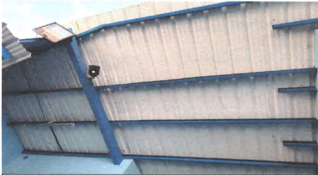
Foto 1: Sustrución de estructura portante de metal en area de patio de escuela de (16 mts x 12 mts) con costanera de 2x4 para tendales y de tubos 4x8 chapa 16 para bases pintados e instalados
