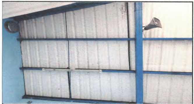
Foto 2: Sustrución de lamina troquelada aluzinc calibre 26 en area de patio de escuela. Con un total de 192 m2 (16 mts x 12 mts)
