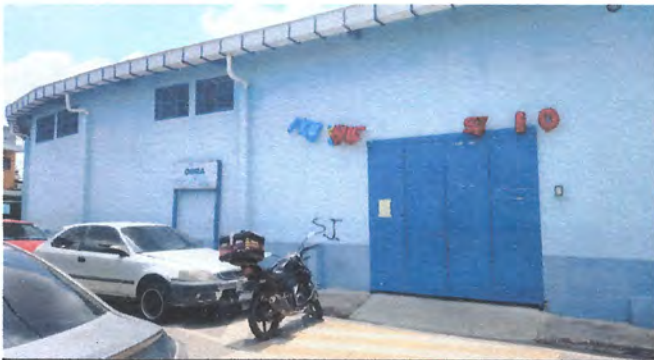
Foto 3: Sustrución de pintura en muros de escuela en area del interior, area de patio y exterior del Instituto se hará con los dos colores asignados por el establecimiento. 300 mts cuadrados.
