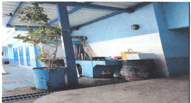
Foto 4: Sustrución de pintura en muros de escuela en area del interior, area de patio y exterior del Instituto se hará con los dos colores asignados por el establecimiento. 300 mts cuadrados.
