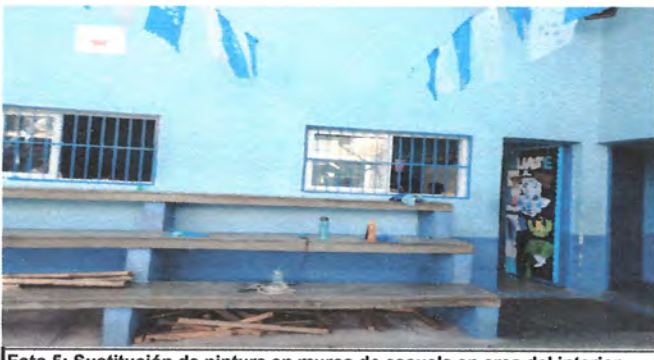
Foto 5: Sustrución de pintura en muros de escuela en area del interior, area de patio y exterior del Instituto se hará con los dos colores asignados por el establecimiento. 300 mts cuadrados.
