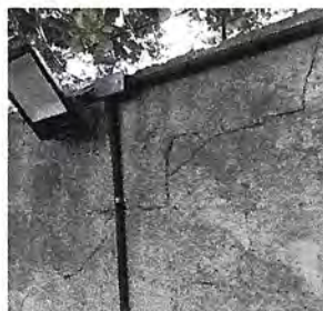
Foto 2: 40 Metros de cernido Monocapa de muro perimetral del lado interno de la Escuela
