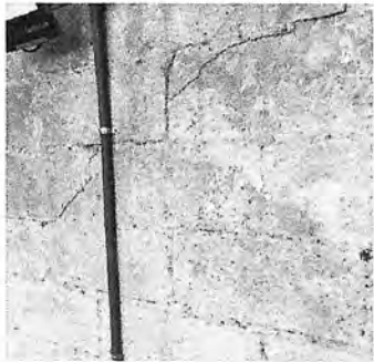
Foto 1: CERCO O MURO PERIMETRAL: Levantado de muro con block de 15x20x40 altura 0.80m se fundiran columnas de concreto armado con varilla de 3/8 y estribo a 0.20m, la distancia entre columnas es de 2.00m.
