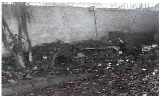
Foto 5: Arreglo de grietas en el muro, cambio del muro en las áreas más dañadas.
