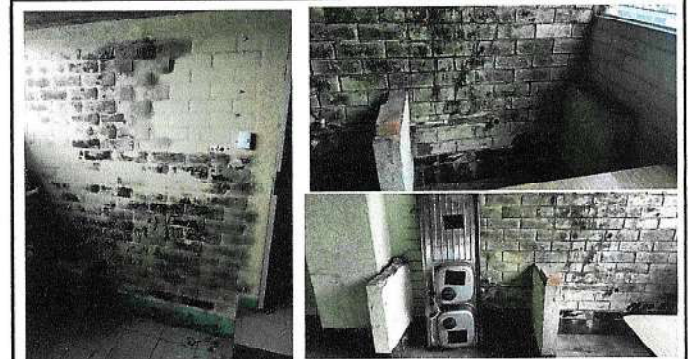
Foto 4: Se requiere de la instalación y habilitación del ambiente que servira para el taller formativo de 4to. Perito sección "A" para que sea apto para ser utilizado por los estudiantes y por el docente del área formativa.
