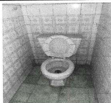
Foto 6: Cambio de inodoros con mangueras, contrallaves y accesorios.
