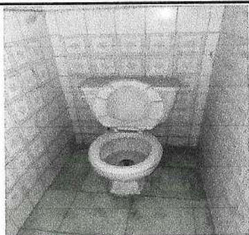
Foto 3: Cambio de inodoros con mangueras, contrallaves y accesorios.
