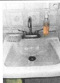
Foto 6: Cambio de lavamanos con pedestal, mangueras, contrallave y accesorios d todo el establecimiento.
