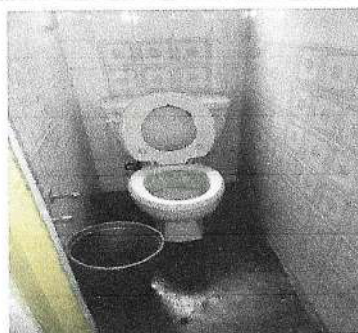
Foto 4: Cambio de inodoros con mangueras, contrallaves y accesorios.
