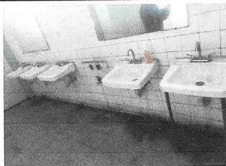
Foto 2: Cambio de lavamanos con pedestal, mangueras, contrallave y accesorios d todo el establecimiento.
