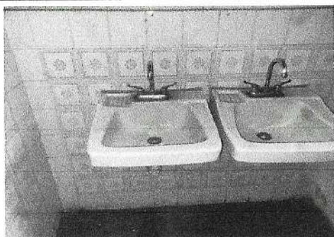
Foto 5: Cambio de lavamanos con pedestal, mangueras, contrallave y accesorios d todo el establecimiento.
