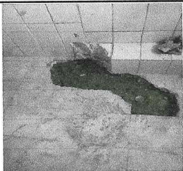
Foto 3: reparación de drenaje de baño de hombres.
