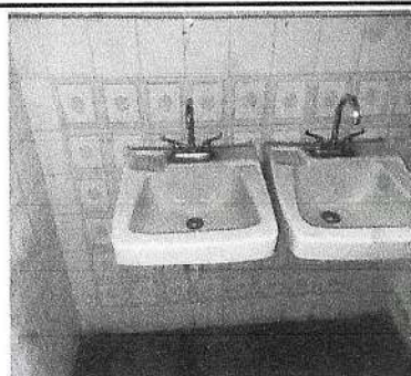
Foto 4: Cambio de lavamanos con pedestal, mangueras, contrallave y accesorios d todo el establecimiento.
