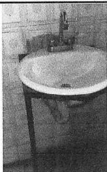
Foto1: Cambio de lavamanos con pedestal, mangueras, contrallave y accesorios d todo el establecimiento.
