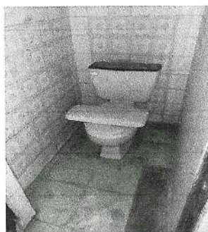
Foto 4: Cambio de inodoros con mangueras, contrallaves y accesorios.
