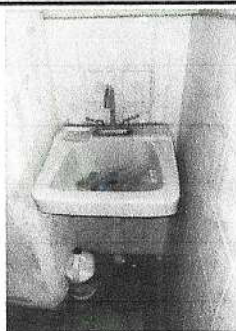
Foto 3: Cambio de lavamanos con pedestal, mangueras, contrallave y accesorios d todo el establecimiento.
