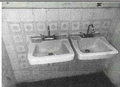
Foto1: Cambio de lavamanos con pedestal, mangueras, contrallave y accesorios d todo el establecimiento.
