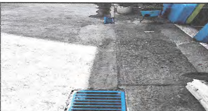
Foto 5: FABRICACIÓN DE DOS REJILLAS PARA CUBIR CUNETA DE DRENAJE AREA DE COCINA, YA QUE SE ACUMULA EL AGUA LLOVEDIZA.
