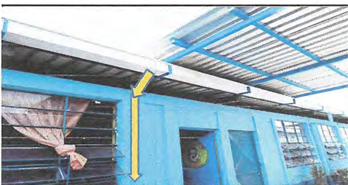
Foto 6: SUSTITUCIÓN DE UNA BAJADA DE AGUA EN AREA DE COCINA, YA QUE SE ACUMULA MUCHA AGUA EN DICHA AREA.
