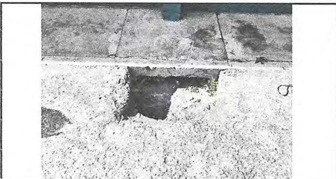
Foto 3: FABRICACIÓN DE UNA REJILLA DE METAL PARA CUBRIR CUNETA DE DRENAJE EN AREA DE PARQUEO YA QUE ES UN HOYO Y ES PELIGROSO PARA LOS NIÑOS Y NIÑAS DE IGUAL MANERA PARA LOS ADULTOS.
